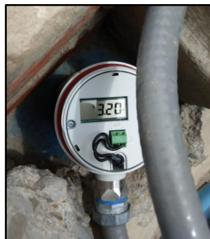
Imagen 3-43: Sensor de Nivel SITRANS LU150 Fuente: Elaboración Propia.
