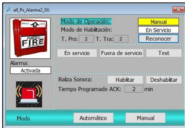
Imagen 3-26: Faceplate Estaciones Manuales Fuente: Elaboración Propia.
