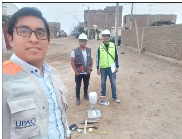
Se observa la ejecución del ensayo densidad natural de campo bajo supervisión del profesional jefe de laboratorio UPAO.
