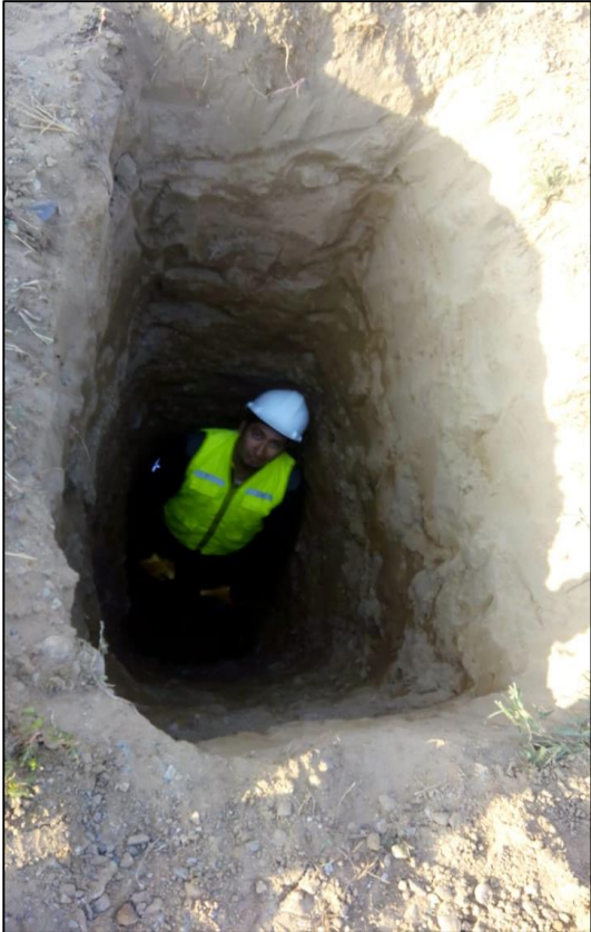
FOTOGRAFÍA N°4 Extracción de muestras de suelo.
