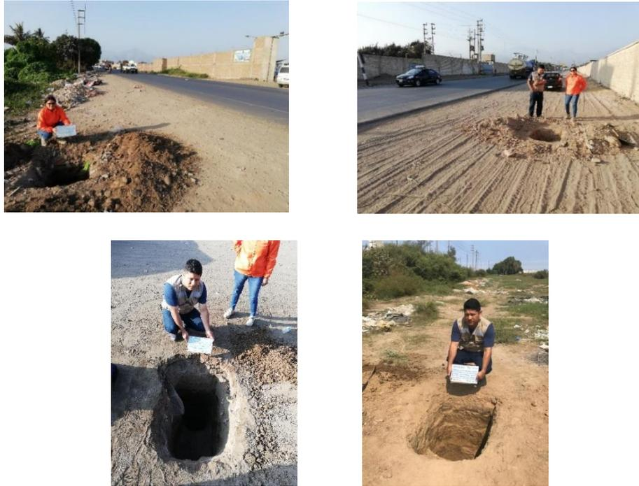
**Figura 11:** Apertura de calicatas para estudio de mecánica de suelos.
