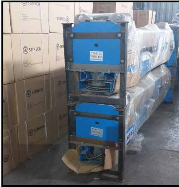
Se encontró elevadores almacenados junto a las cajas de filtros.
