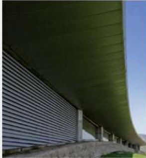
El panel Sandwich Wall es un producto arquitectónico con características aislantes, fabricado en 50 y 35 mm de espesor y en anchos estándares de 300 / 470 / 500 / 565 / 600 mm con un largo máximo de 9,8 m. Compuesto por dos planchas metálicas de aluzinc en espesor 0,6 mm, separadas entre sí por poliuretano inyectado de densidad 60 kg/m<sup>3</sup>.
