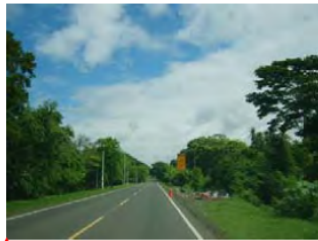
Figura 3.1.4.1 Camino rural de dos carriles con hombro pavimentada y vegetación rala.
