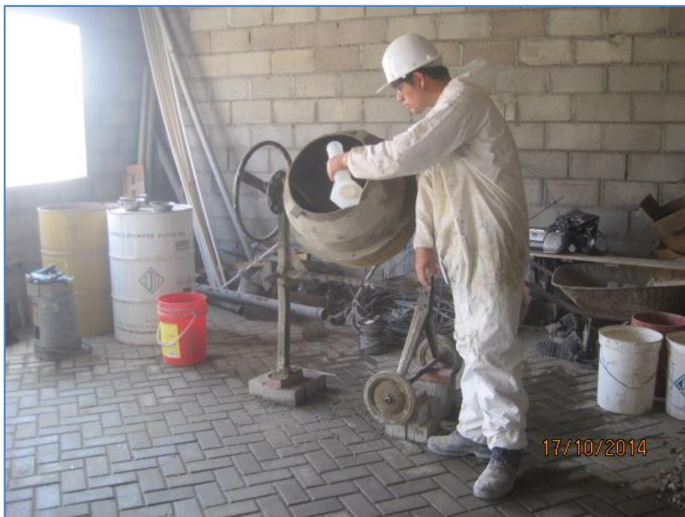
FOTO N°9 Elaboración de la mezcla de concertó Autocompactante
