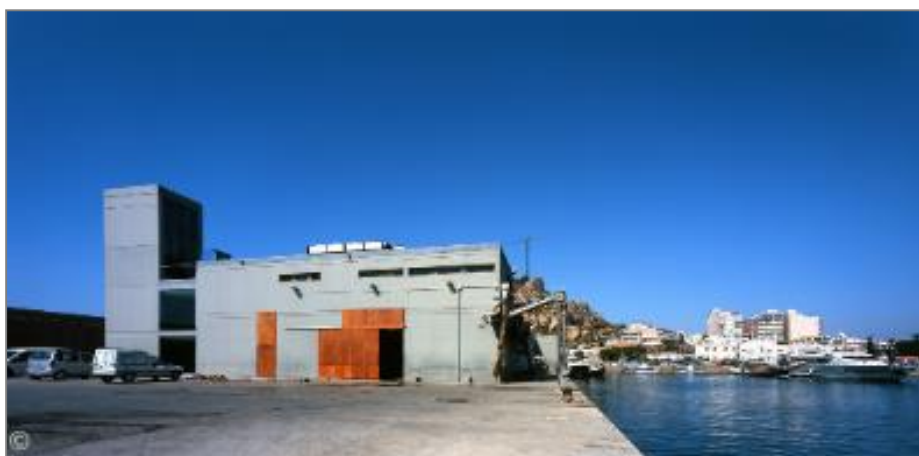
Imagen N°07: Fachada Lateral / zona de despacho.
