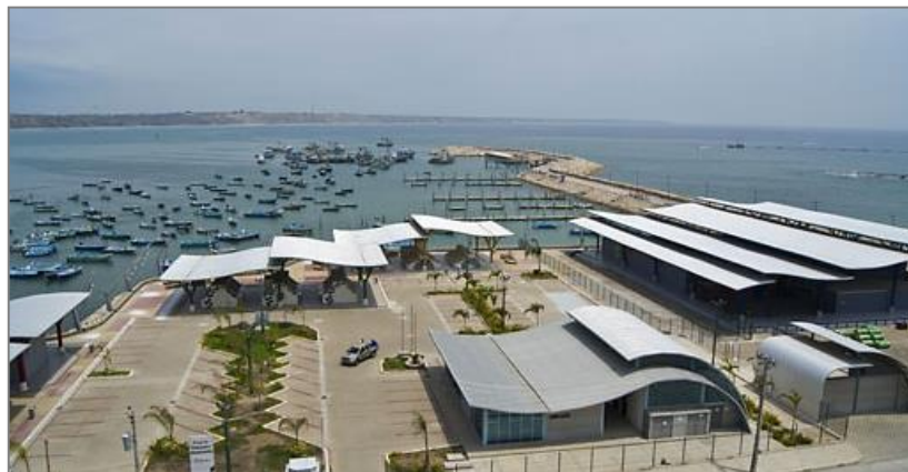
Imagen N°02: Infraestructura de proyecto en Puerto Anconcito, El Guayas
