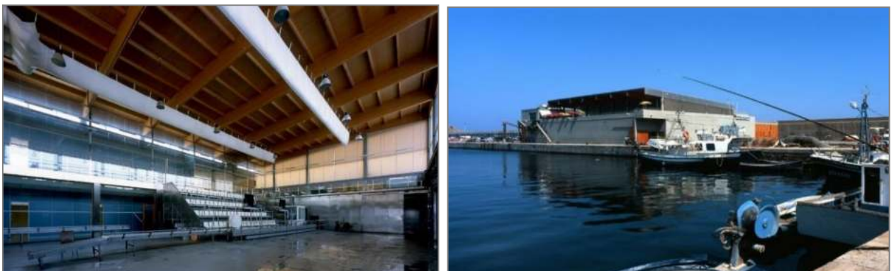
Imagen N° 127: Infraestructura Puerto Pesquero y Deportivo Águilas
