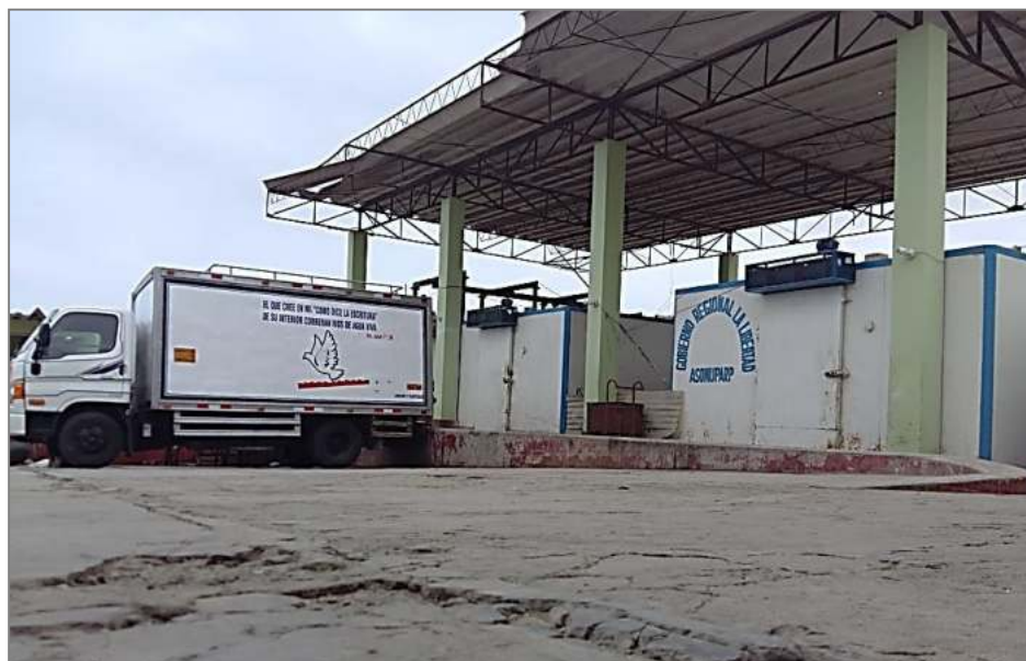
Imagen N°18 y N°19: Zona de desembarque servicio y patio de maniobras.
