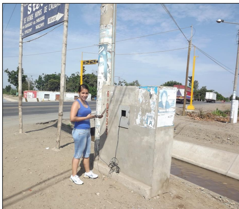
Figura III - 10. Toma de Lectura de Los Medidores Eléctricos
