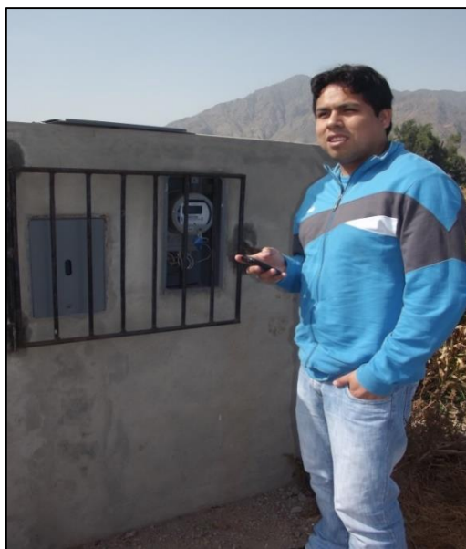
Figura III - 14. Recepción de cobertura celular GSM, a través de un equipo celular
