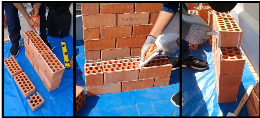
FIGURA N° 59: Elaboración de los muretes con 2 cordones de masa (izquierda), 3 cordones de masa (centro) y 2 cordones en la junta vertical y horizontal (derecha)
