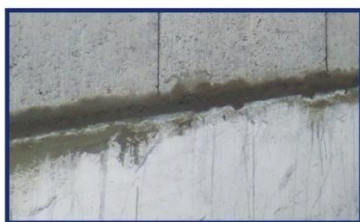
Nivelamiento primera hilada
