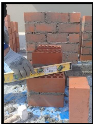
FIGURA N° 52: Nivelación durante la construcción de las pilas asentadas con mortero tradicional
