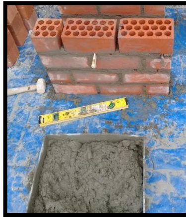
FIGURA N° 67: Preparación del mortero 1:5 y asentado de las unidades de albañilería
