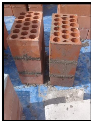
FIGURA N° 53: Pilas de albañilería asentadas con mortero tradicional de 3 ladrillos de altura
