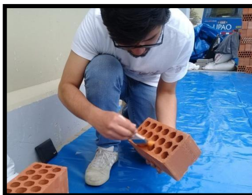
FIGURA N° 58: Limpieza de las unidades de albañilería antes de la colocación del producto
