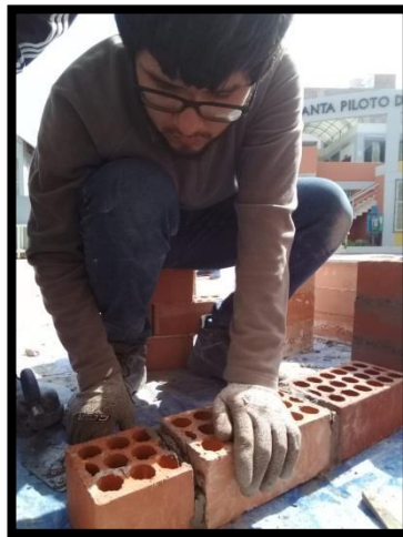
FIGURA N° 68: Asentado de las unidades de albañilería con mortero tradicional
