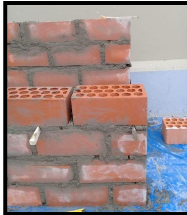
FIGURA N° 69: Uso de cuñas para mantener una junta constante de 1.5 cm
