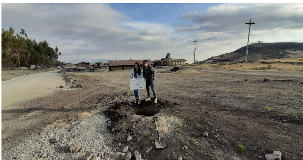
Figura 8: Excavación de pozos explorativos.
