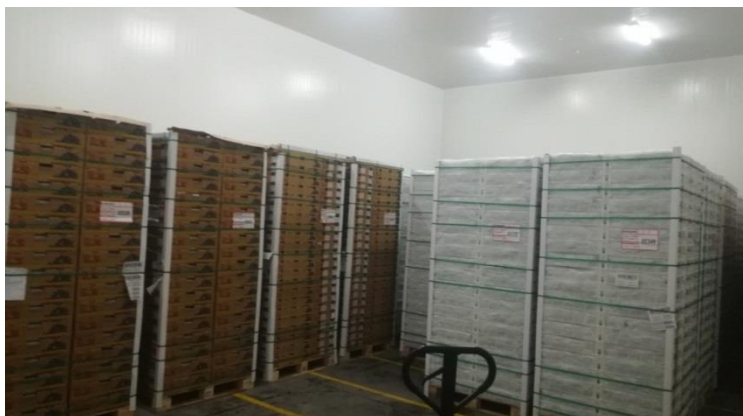
Figura N° 26 Cámara de frío
