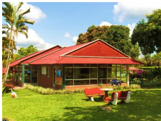
Figura Nº 9: Centro Recreacional del Fondo de Empleados
