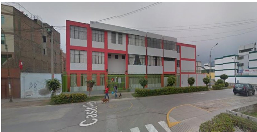
IMAGEN N° 20: Vista lateral del Instituto PAENFTS - PERÚ FUENTE: Google Earth - PAENFTS
