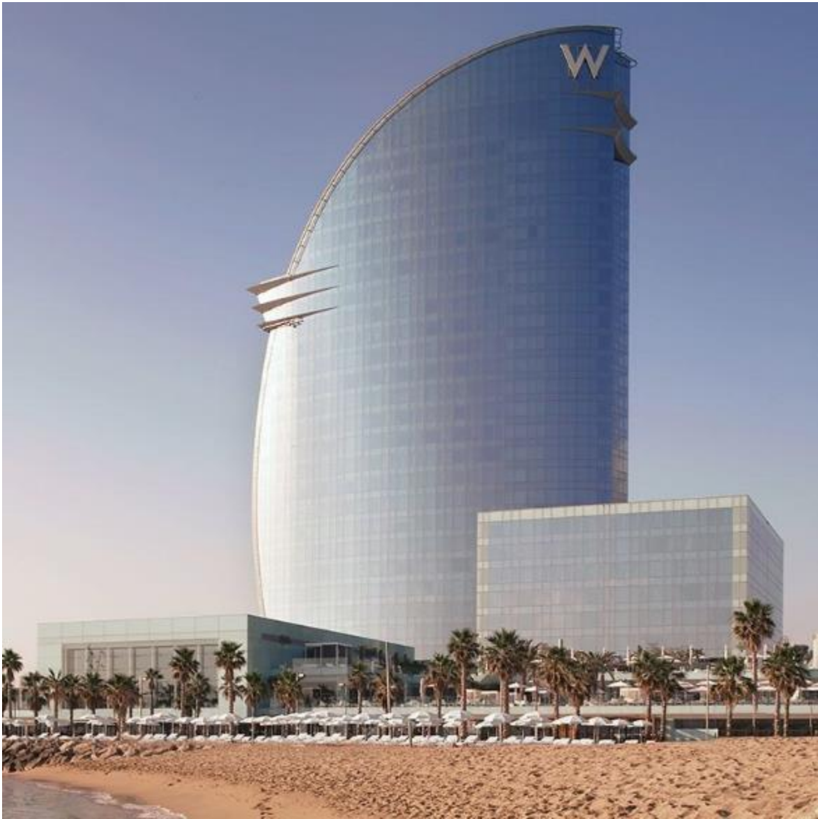
IMAGEN N° 09: Vista del Hotel W Barcelona, Marriott, 6 Estrellas
