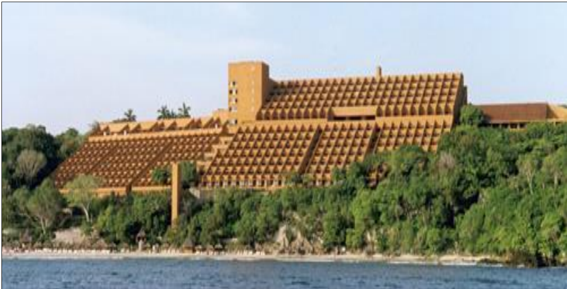
IMAGEN N° 13: Vista General del Hotel acoplado a la Topografía
