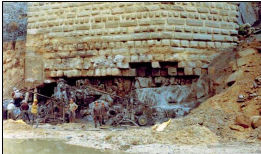
*Imagen 4: Socavación en un pilar del puente de Alcántara.
