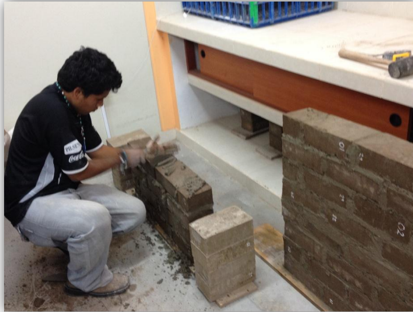
Figura N° 24: Rellenando las juntas verticales
