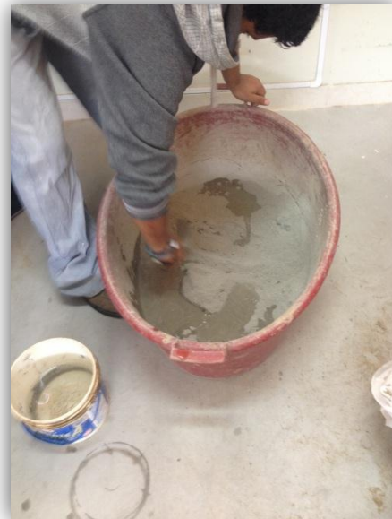
Figura Nº 19: Elaboración del mortero 1:1/2:4 (Cemento, Cal y Arena)
