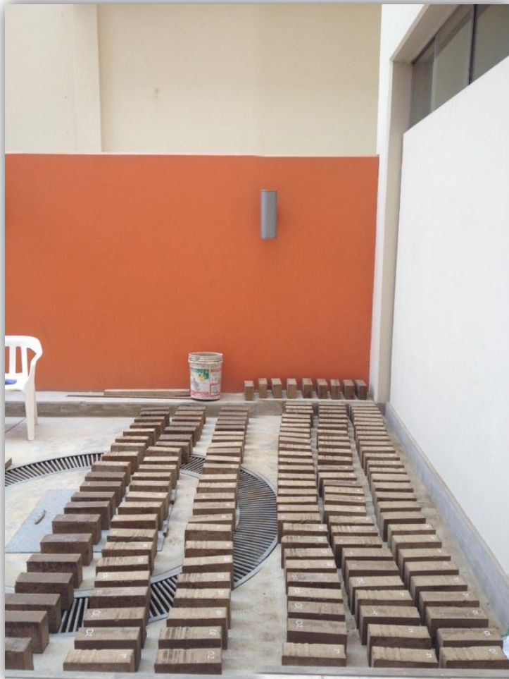
Figura Nº 15: Curado y acopio de las unidades
