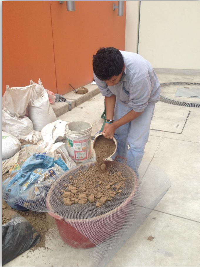
Figura N° 7: Tamizado del suelo
