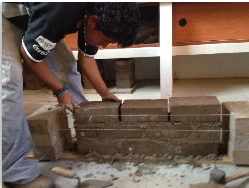
Figura N° 23: Asentando las unidades de albañilería antes de su nivelación
