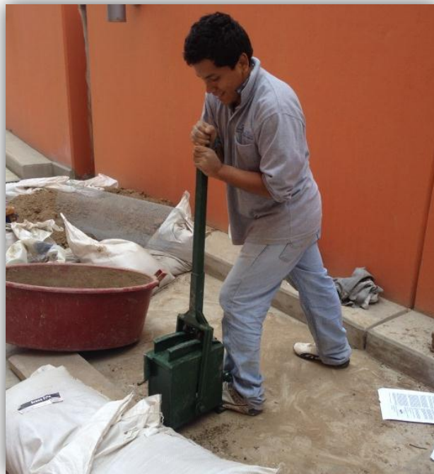
Figura N°13: Compactación del material
