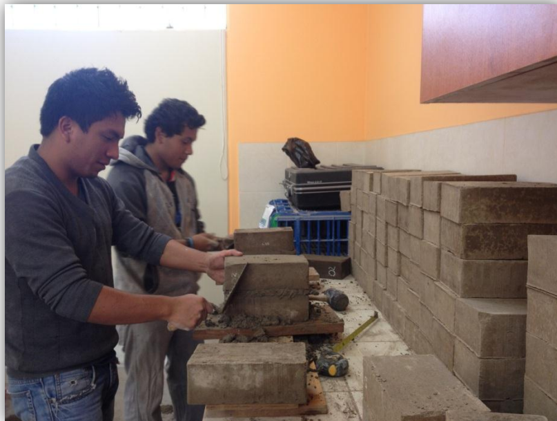
Figura N° 21: Verificando el grosor de la junta horizontal
