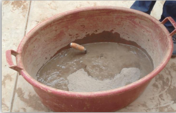
Figura N° 11: Adición del agua a la mezcla
