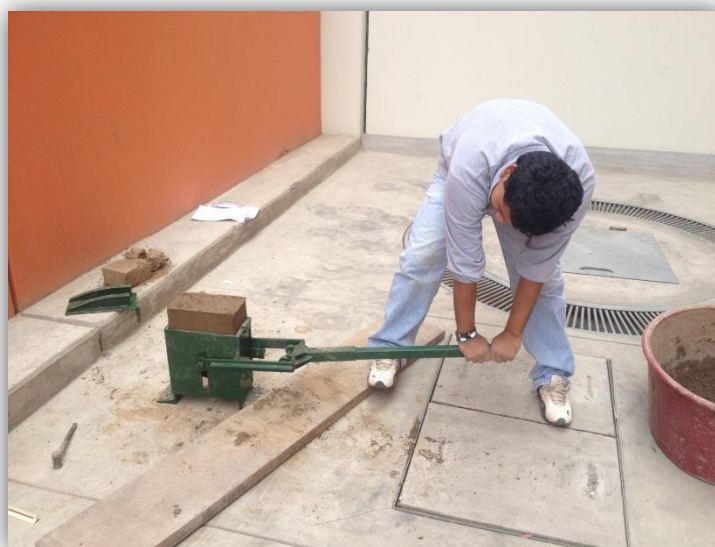
Figura Nº 14: Extracción de la unidad compactada
