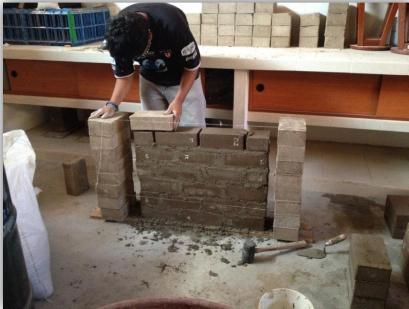
Figura N° 27: Construcción de Muretes
