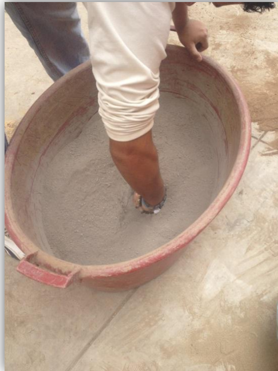
Figura Nº 9: Mezcla del suelo y el cemento
