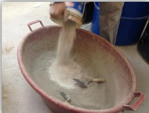
Figura Nº 19: Elaboración del mortero 1:1/2:4 (Cemento, Cal y Arena)
