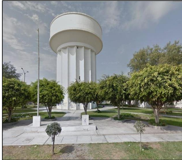
Figura N° 10: Reservorio Tipo Fuste ubicado la Urbanización Covicorti.
