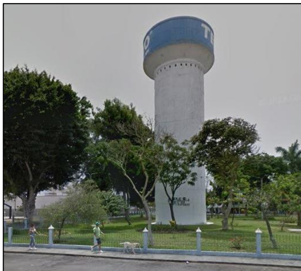
Figura N° 14: Reservoirio Tipo Fuste ubicado en la Urbanización San Andrés – 1ra Etapa.
