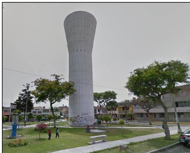
Figura N° 11: Reservorio Tipo Fuste ubicado en la Urbanización La Noria.
