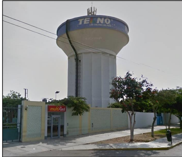
Figura N° 13: Reservoirio Tipo Fuste ubicado en la Urbanización Monserrate.
