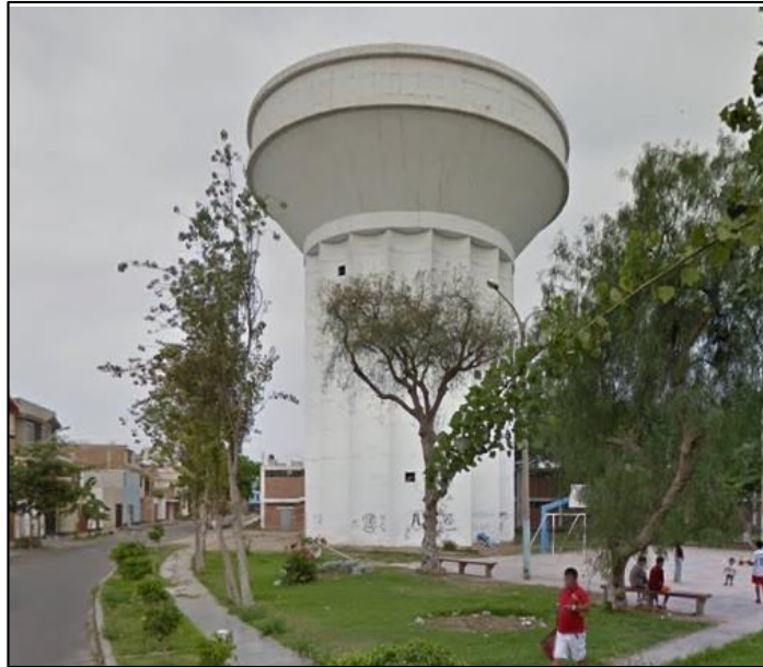
Figura N° 16: Reservorio Tipo Fuste ubicado en la Urbanización Santa Inés.
