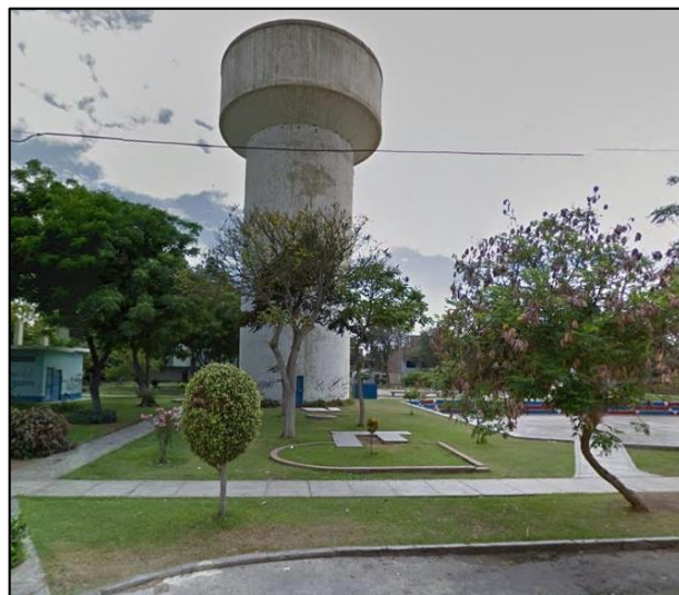
Figura N° 12: Reservorio Tipo Fuste ubicado en la Urbanización Santo Dominguito.
