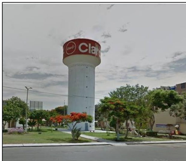
Figura N° 15: Reservoirio Tipo Fuste ubicado en la Urbanización San Andrés – 2da Etapa.
