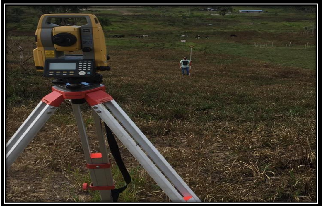
Ilustración 1: montaje de la estación total in situ.
