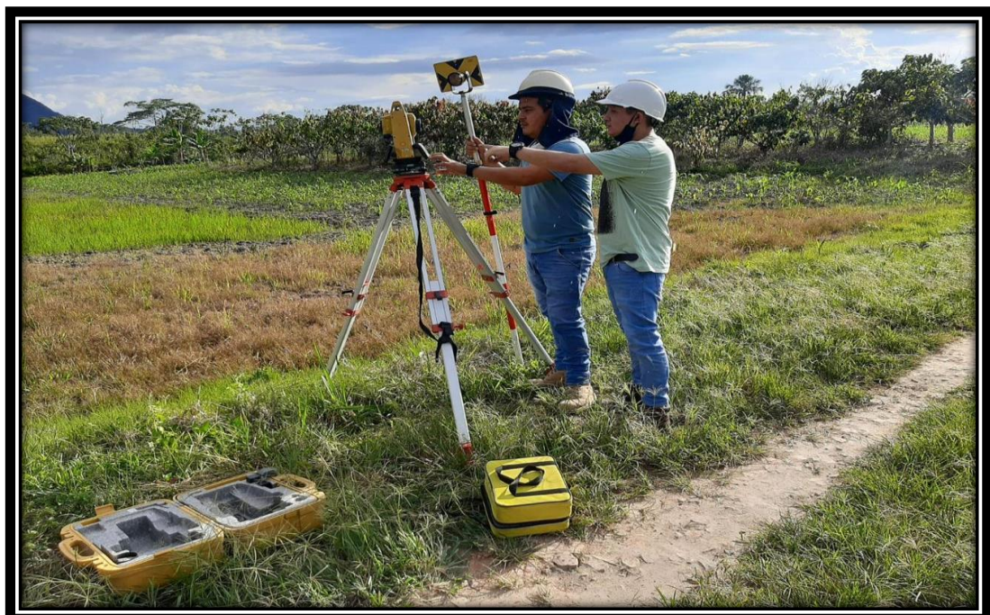
Ilustración 4: Elección, marcado de punto de control topográfico in situ.
