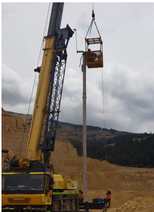
Fotografía 5: Corte de Casing con equipo de bombeo instalado.
