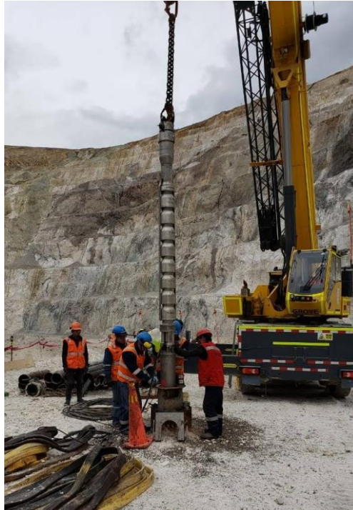
Fotografía 4: Instalación de equipo de bombeo.
