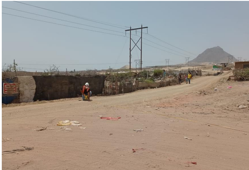
Figura 23. Trabajo de Campo – medición de buzón a buzón proyectado
