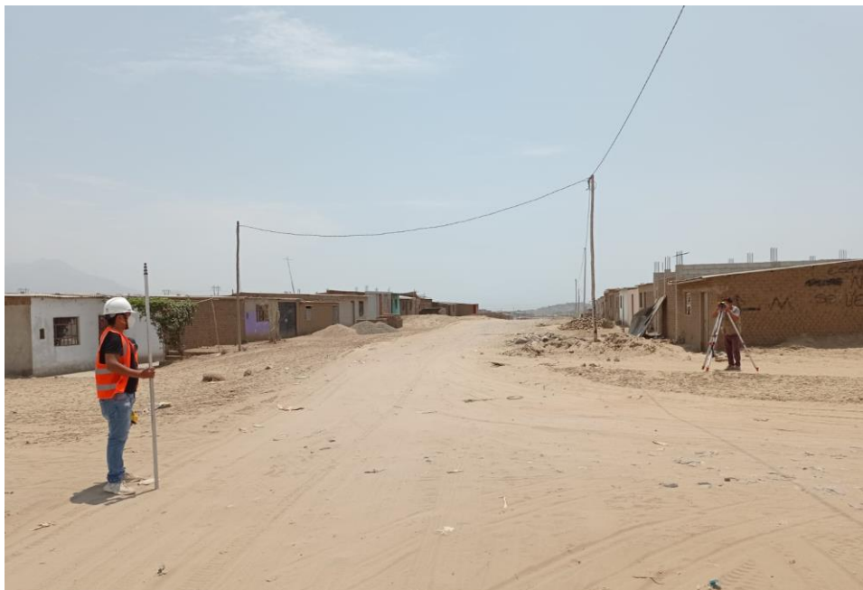
Figura 24 Trabajo de Campo - Levantamiento Topográfico de la zona
