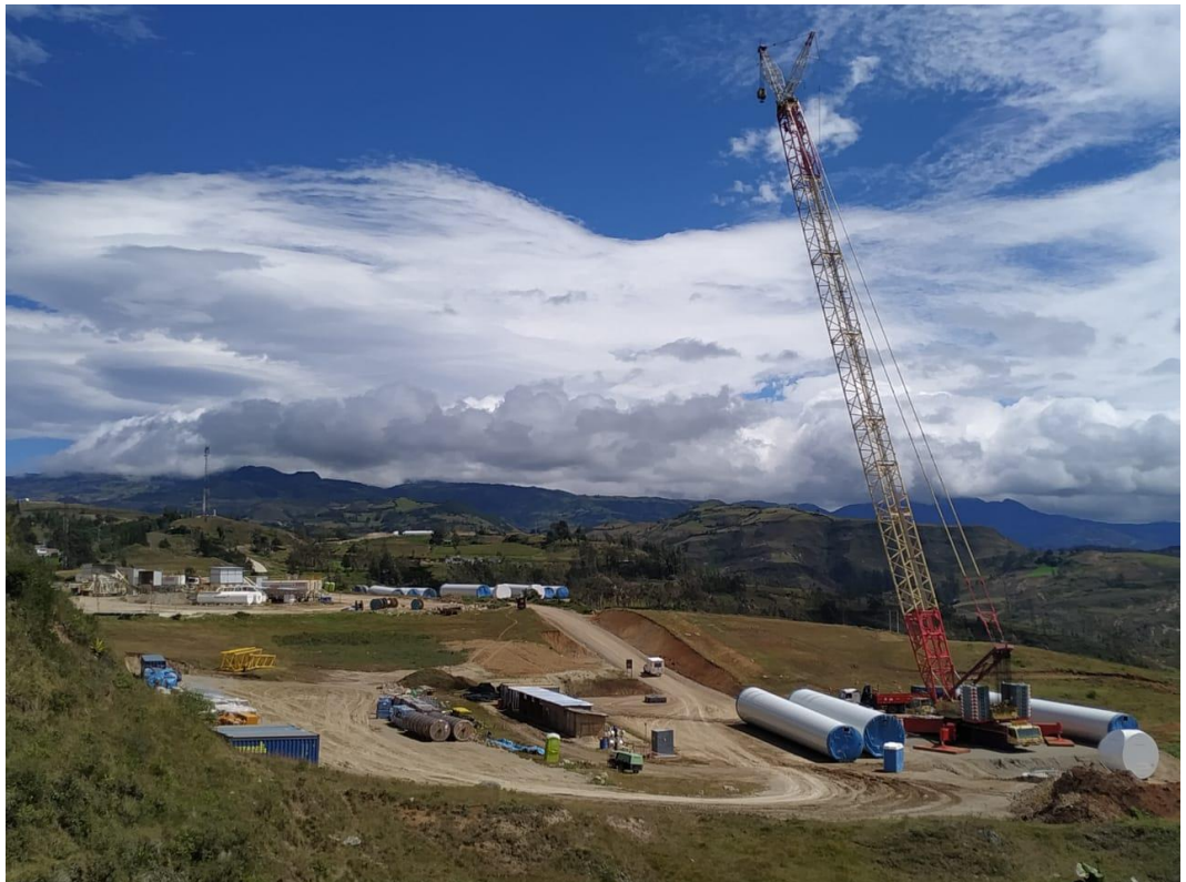
Figura 3.6 - Montaje del Parque Eólico Duna Huambos.
