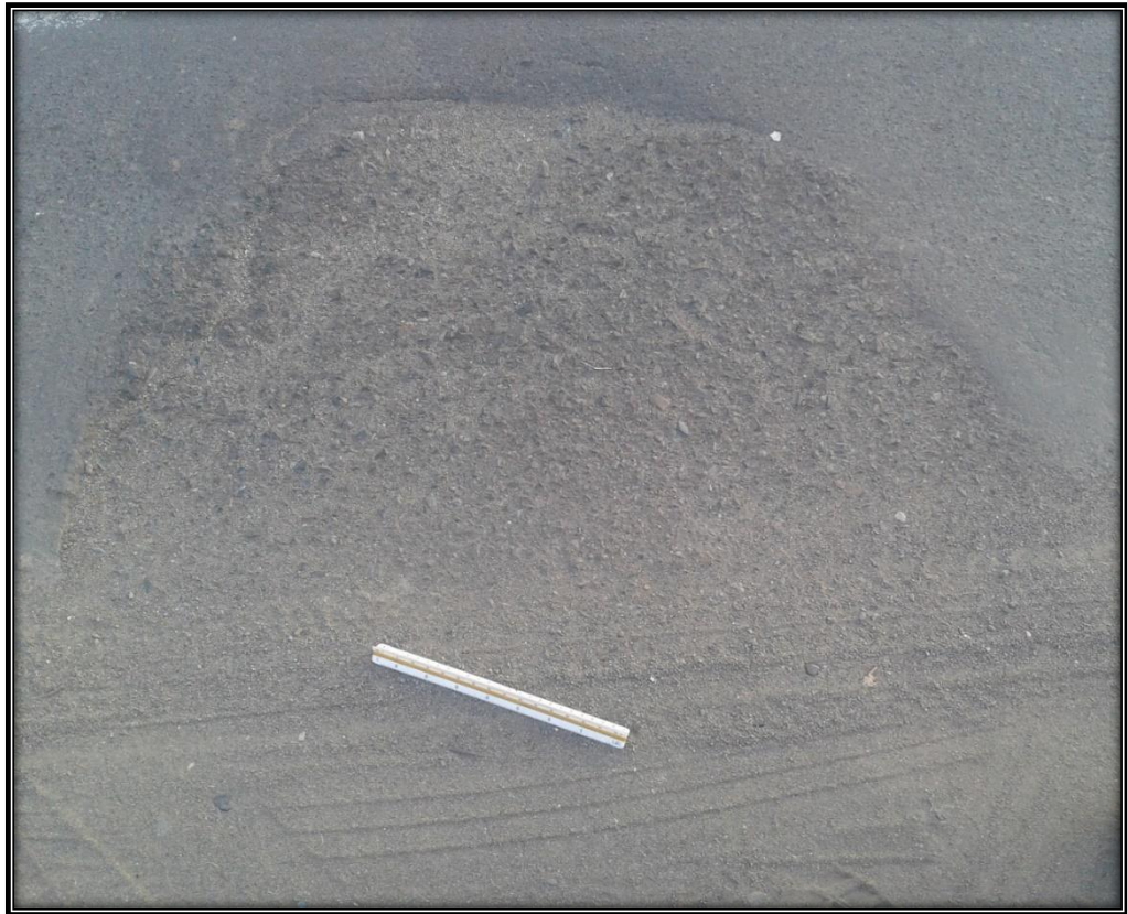
Imagen 12 – Falla por meteorización UM-I04 Fuente: Propia
