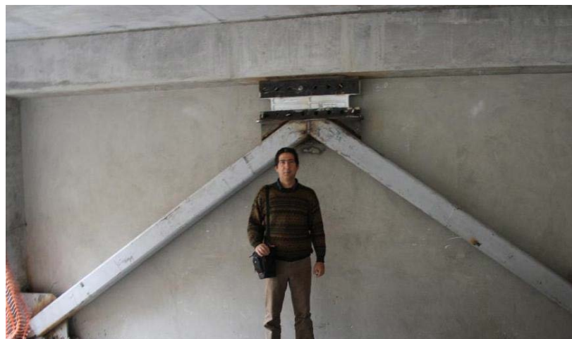
Figura N° 61: Disipadores Shear Link Bozzo Elaboración Bozzo et al 1999
