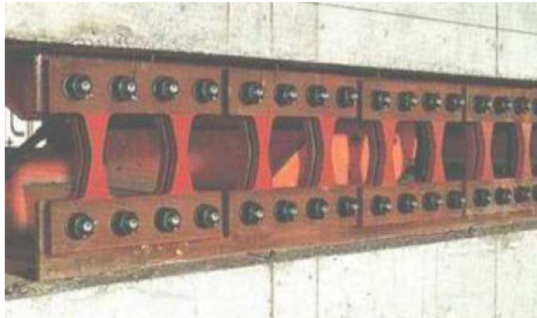
Figura N° 60: Disipadores Panal Elaboración Bozzo et al 1999
