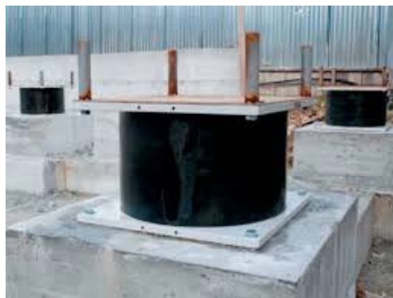
Figura N° 54: Aislador sísmico de elastómero Elaboración propia
