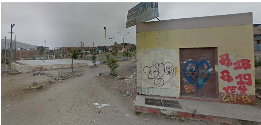
IMAGEN N°07: Local Comunal del Territorio I en estado de abandono
