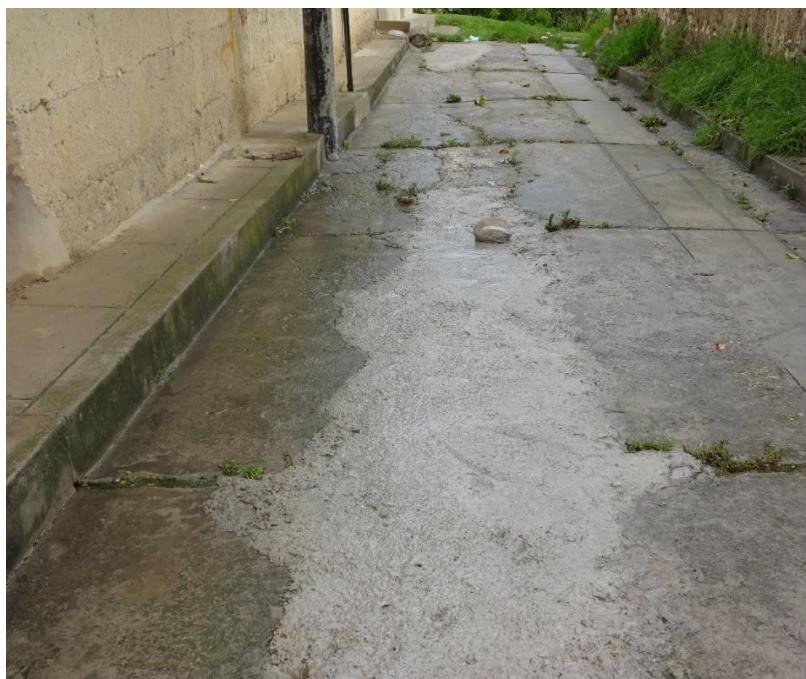
Imagen N° 66. Jr. Sucre con deterioro del sello de junta, grietas lineales y parche grande
