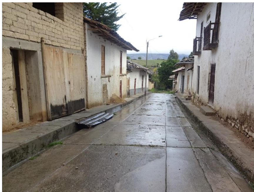
Imagen N° 57. Falla de tipo parche grande y pulimento de agregados presente en el Jr. Sucre
