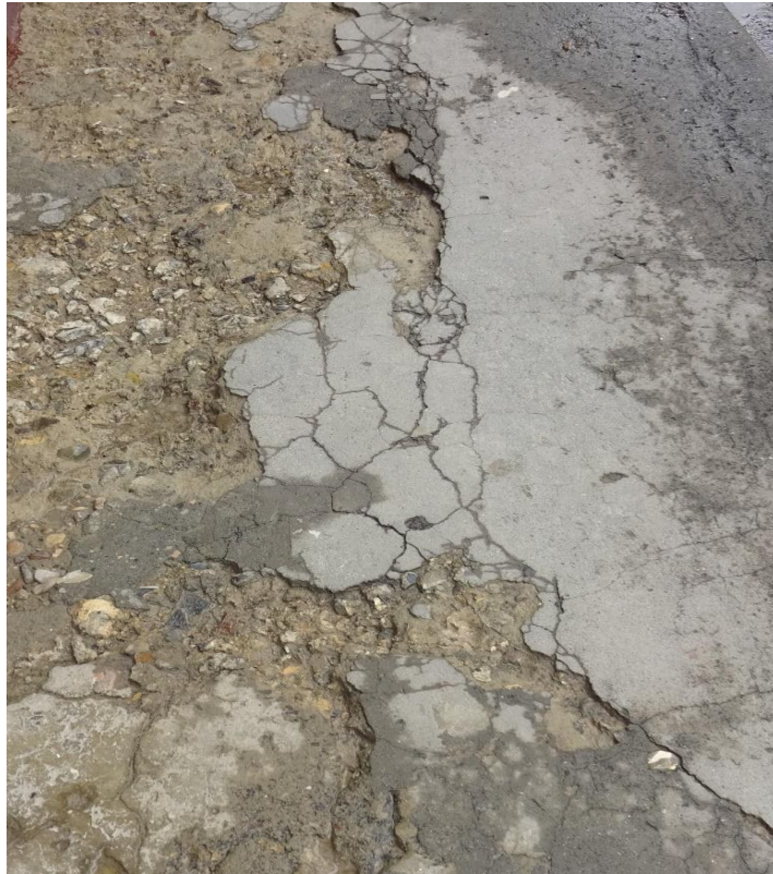
Imagen N° 64. Jr. Huayna Cápac con pulimento de agregados
