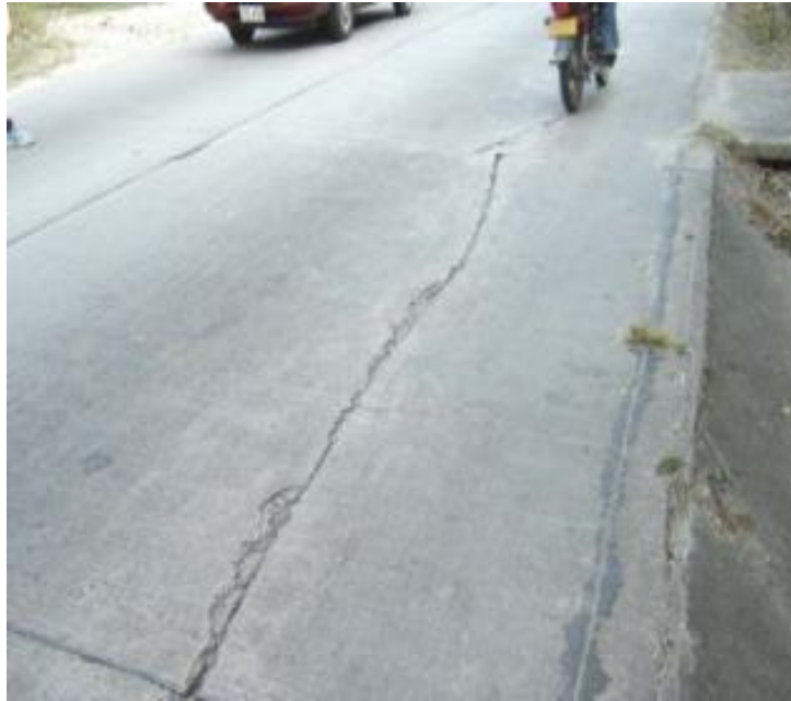
Imagen N° 9. Grieta longitudinal
