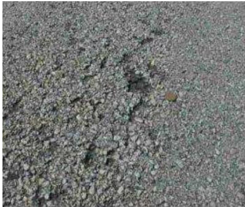
Imagen N° 13. Pulimento de grado de severidad alta
