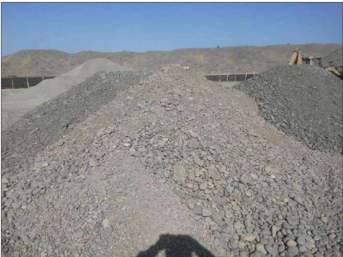
Fotografía N° 02: Vista del material de hormigón acopiado en obra
