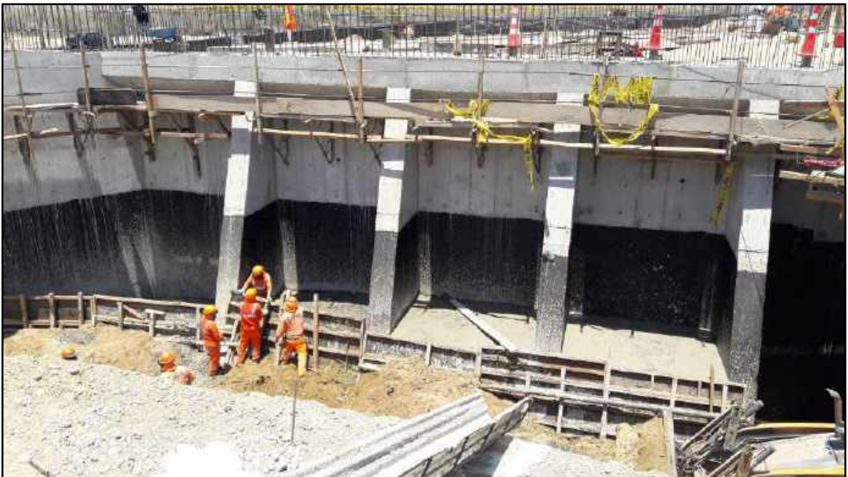
Fotografía N° 08: Encofrado y vertido de concreto de relleno fluido en zona de contrafuertes
