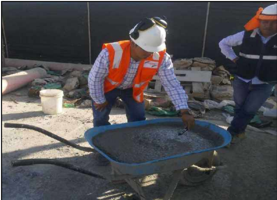
Fotografía N° 26: Control de Temperatura del Concreto
