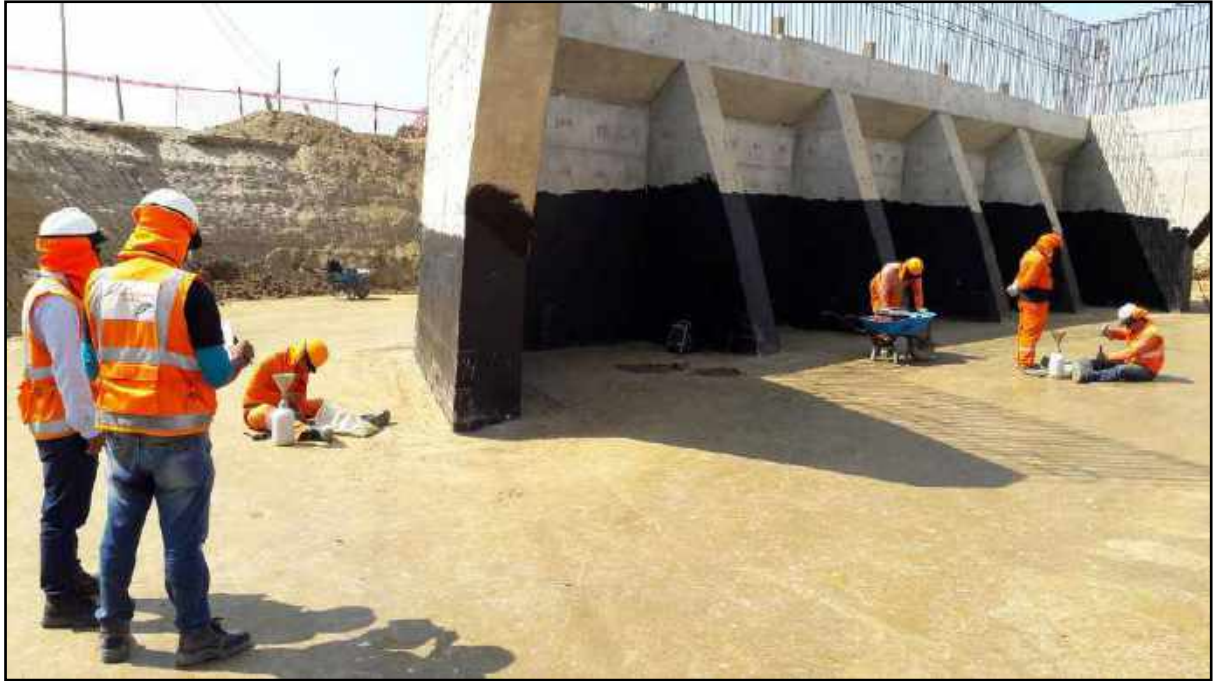
Fotografía N° 15: Obtención de densidad de campo mediante el método del cono de arena
