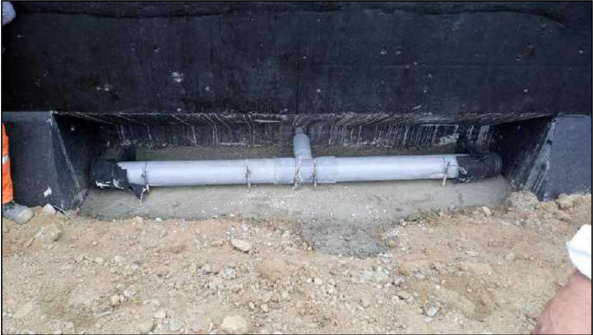
Fotografía N° 23: Relleno Fluido en parte de Contrafuerte para colocación de tubería
