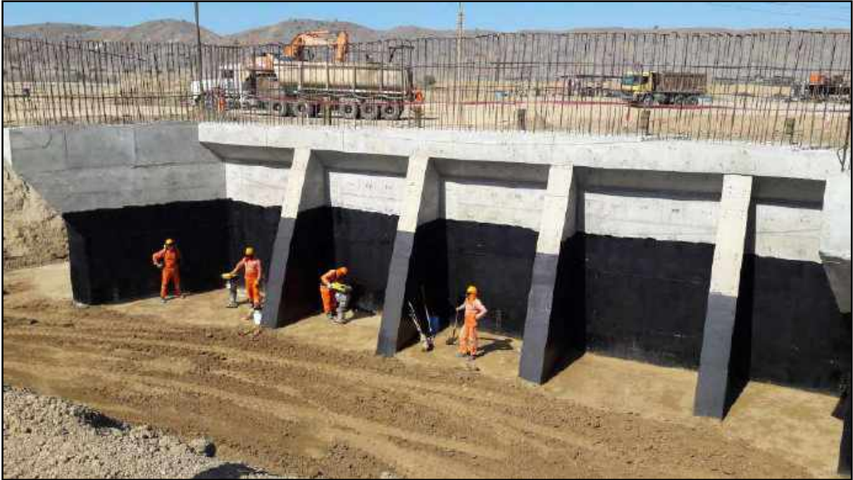
Fotografía N° 13: Trabajos de relleno estructural en zona de contrafuertes mediante vibroapisonadores
