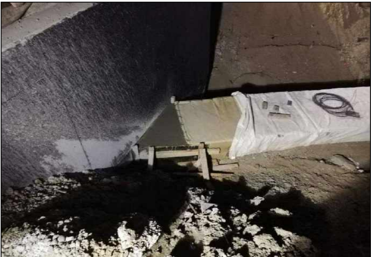
Fotografía N° 24: Relleno Fluido en parte de Geobolsa sirve como alternativa de relleno
