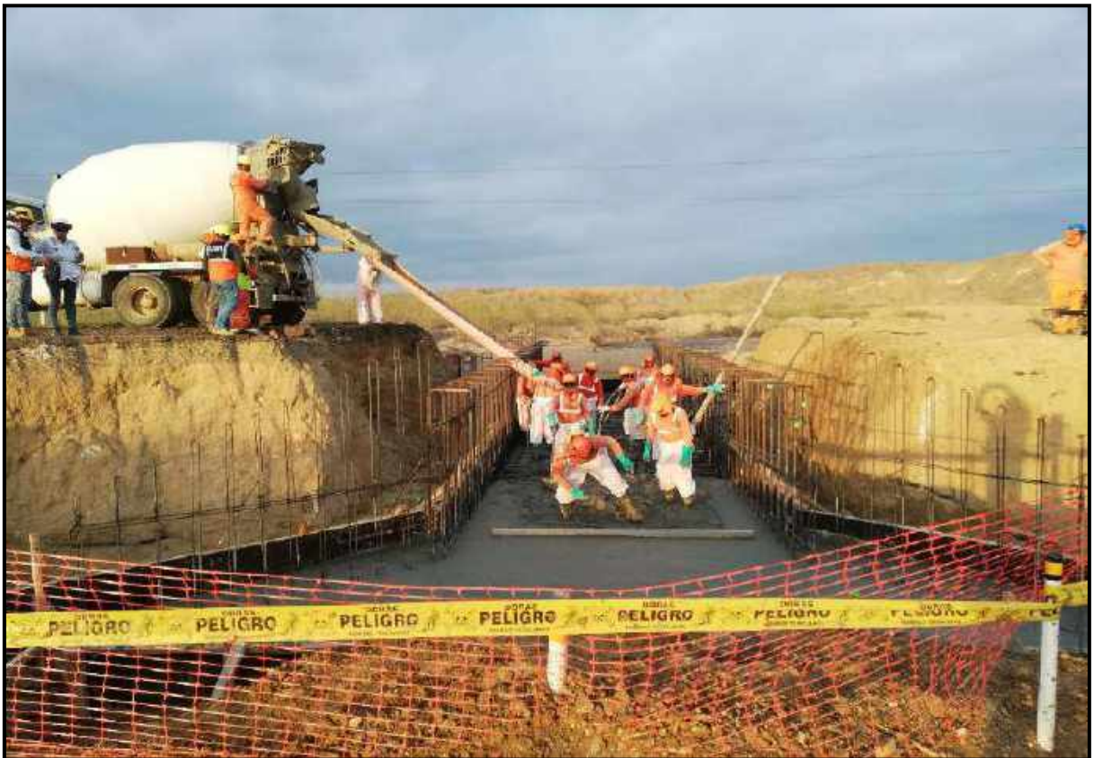
Fotografía N° 34: Vaciado de la losa inferior
