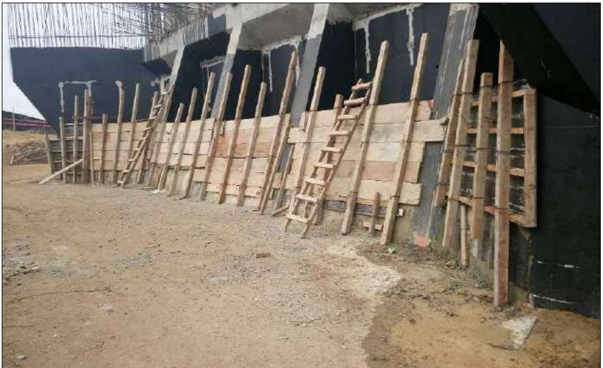
Fotografía N° 10: Vista del encofrado entre aleros y contrafuertes para relleno fluido
