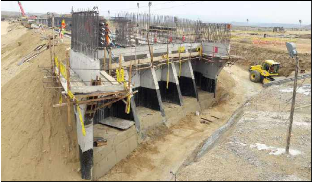
Fotografía N° 09: Vista de contrafuertes con relleno fluido (concreto pobre)
