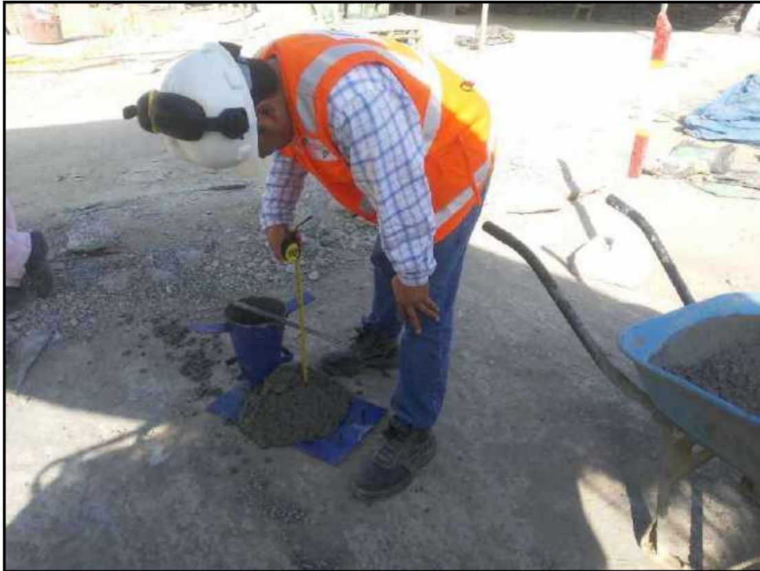
Fotografía N° 27: Control de Slump del Concreto
