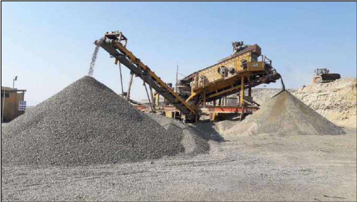
Fotografía N° 01: Procesamiento de agregados en Cantera - Planta Mallares
