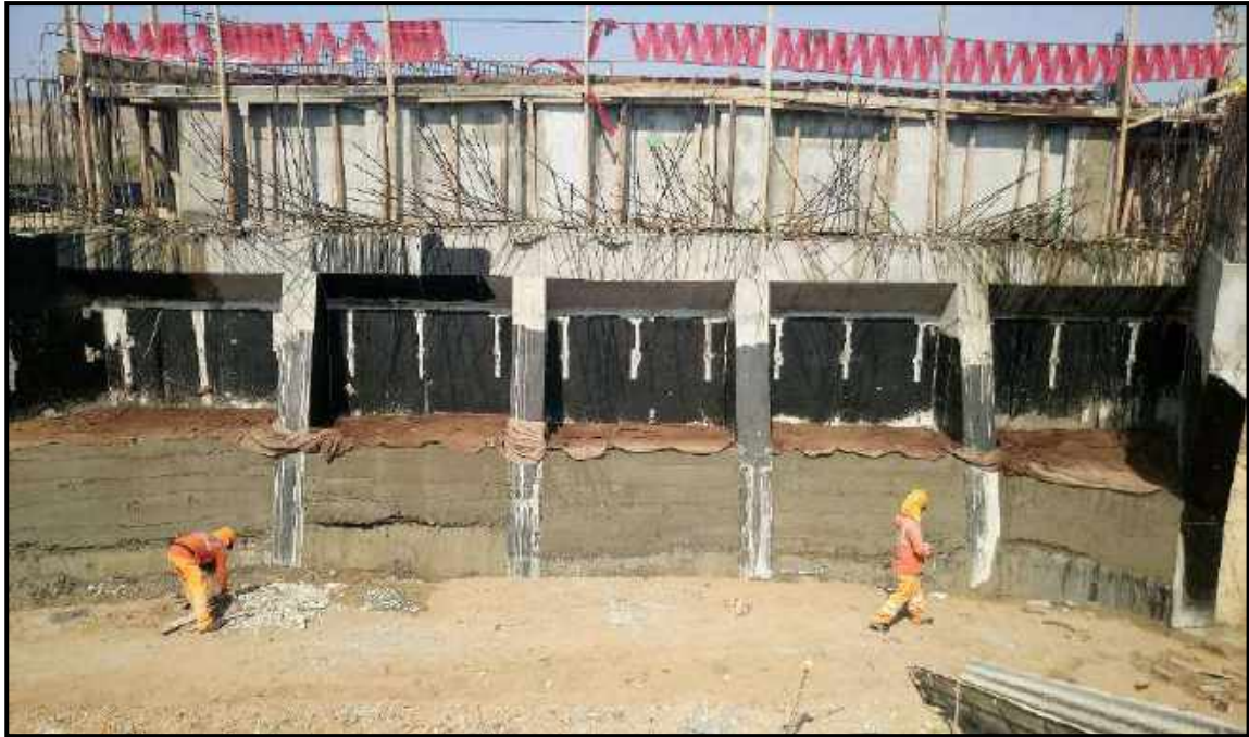
Fotografía N° 11: Relleno fluido de concreto f'c=30 Kg/cm 2 en proceso de curado
