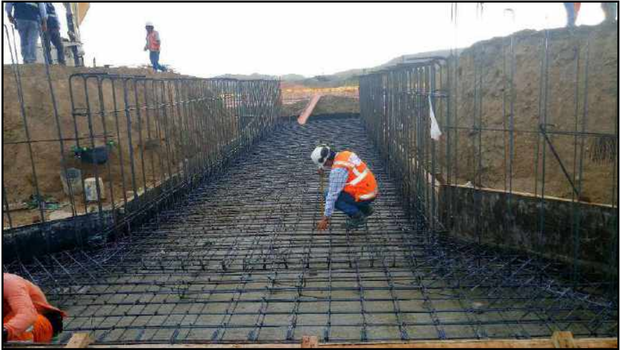
Fotografía N° 33: Control de espesor de losa inferior de nueva alcantarilla tipo marco
