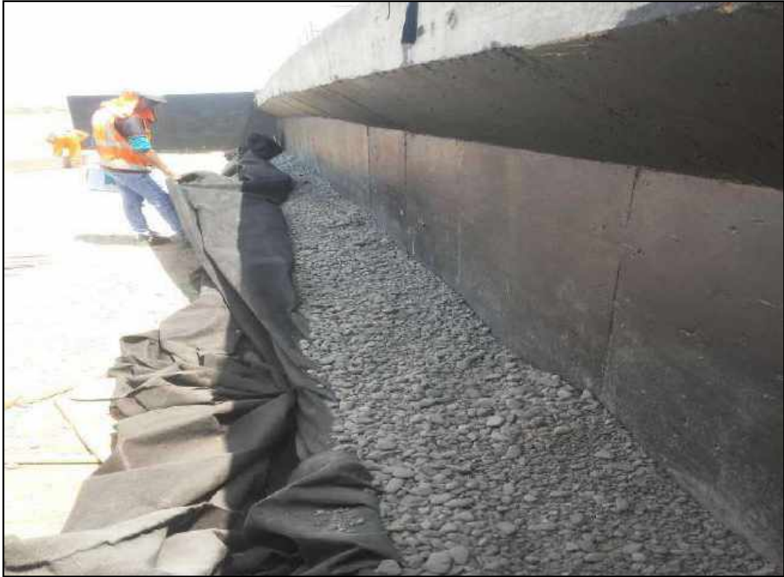
Fotografía N° 25: Capa filtrante de gravilla después del relleno Fluido
