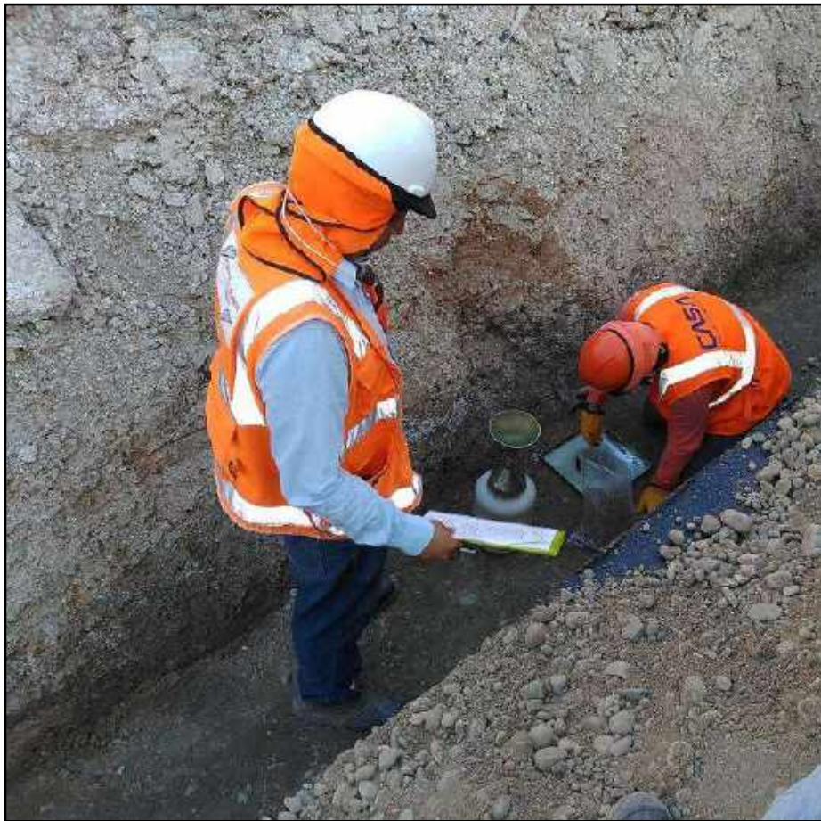
Fotografía N° 12: Obtención de densidad de campo en rellenos estructurales
