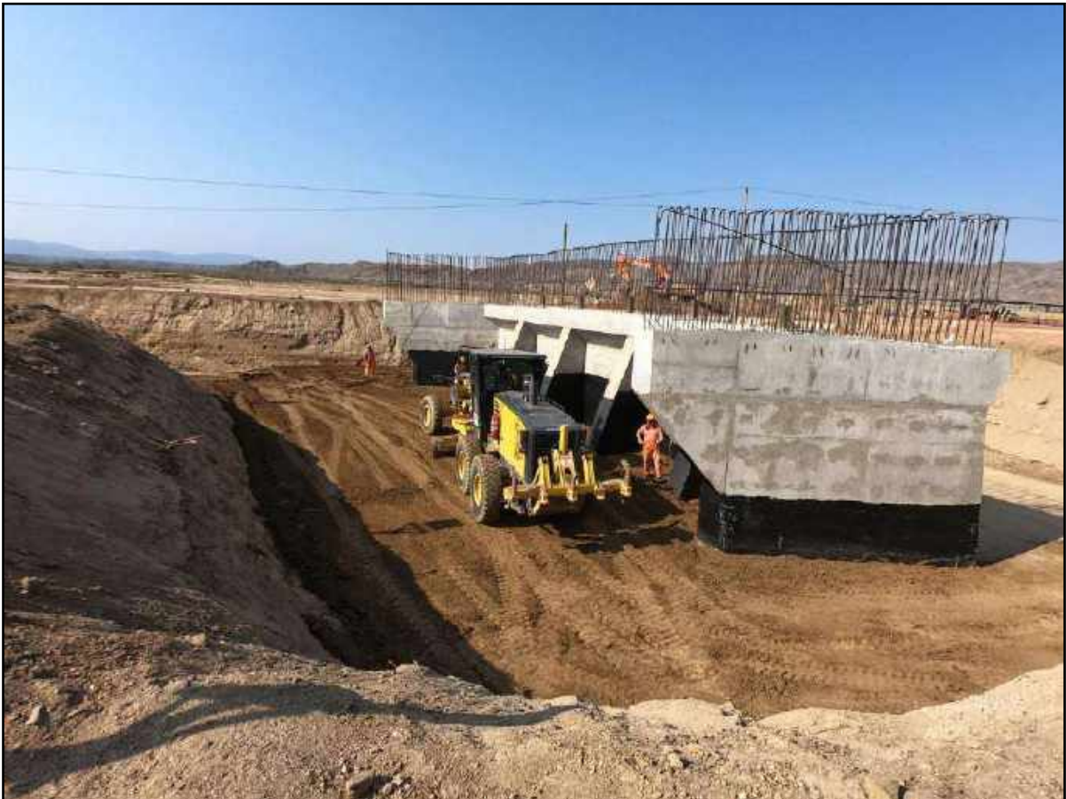
Fotografía N° 14: Extendido de material granular mediante motoniveladora
