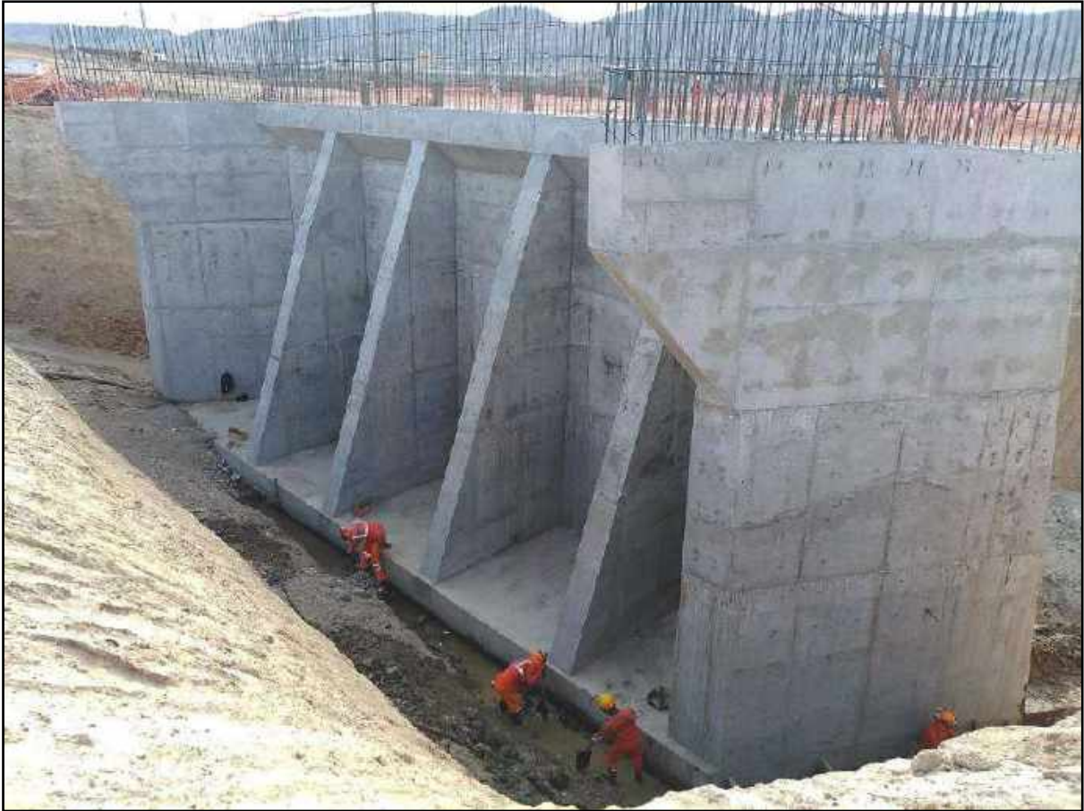
Fotografía N° 05: Limpieza manual de parte lateral de zapata de estribo antes de proceder a la aplicación de relleno fluido.
