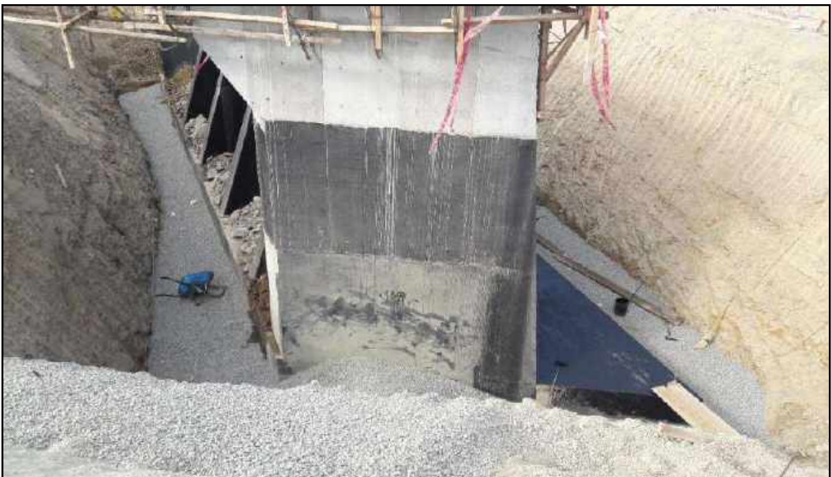
Fotografía N° 06: Colocación de capa de grava por drenaje alrededor de la zapata
