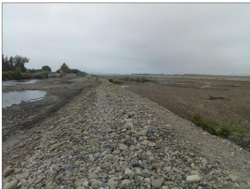
Figura N° 37: Canal de aproximación para la bocatoma Chicamita
