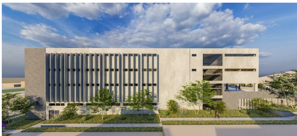
Imagen 70: Vista lateral posterior de CETPRO Fuente: Elaboración propia
