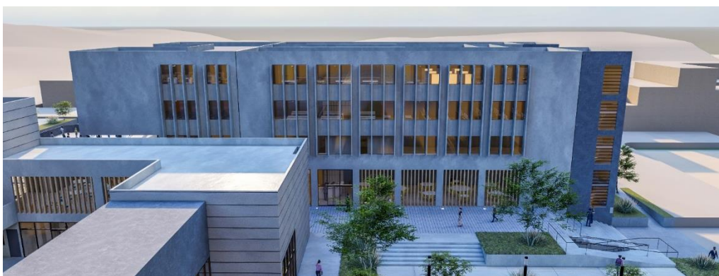
Imagen 105: Fachada de lamas verticales Fuente: Elaboración propia
