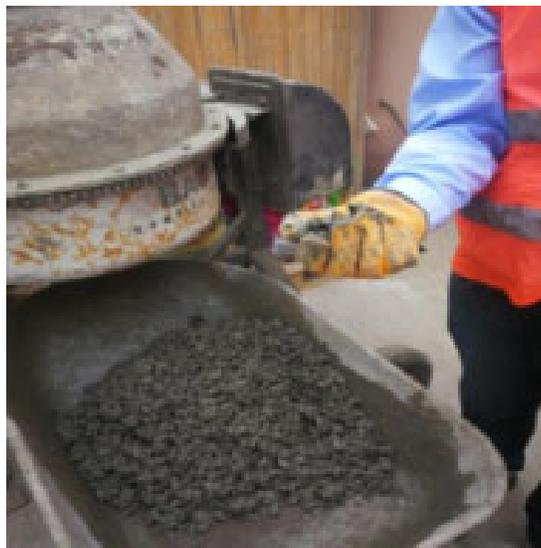
**Imagen 14.** Mezclado de concreto
