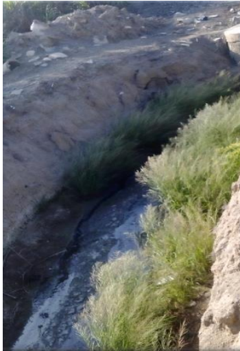
Ilustración 14: Canal donde se transporta todo el desagüe del Anexo de Nazareno.
