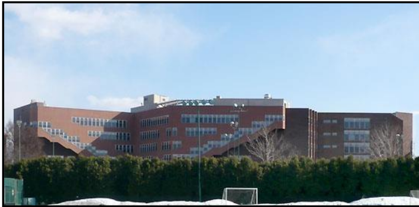
FACHADA NORTE - FUENTE: Elaboración Propia.
