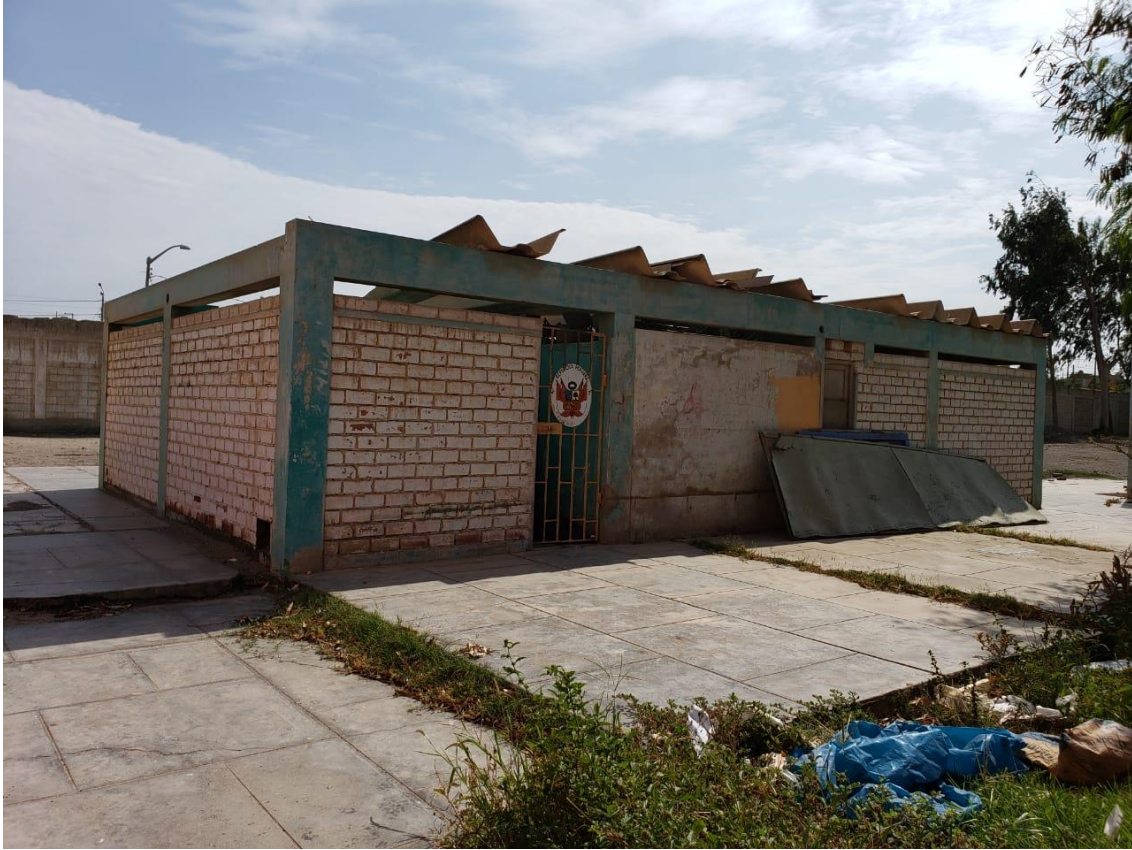
Imagen 13: Baños en desuso del pabellón C
