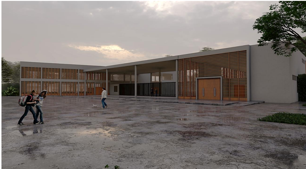
Imagen 51: Fachada - Fuente: Propia
