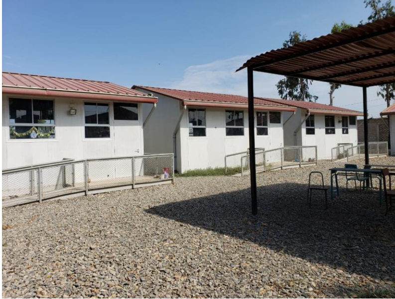
Imagen 16: Caseta para auxiliares en el área de las aulas prefabricadas. Fuente propia.
