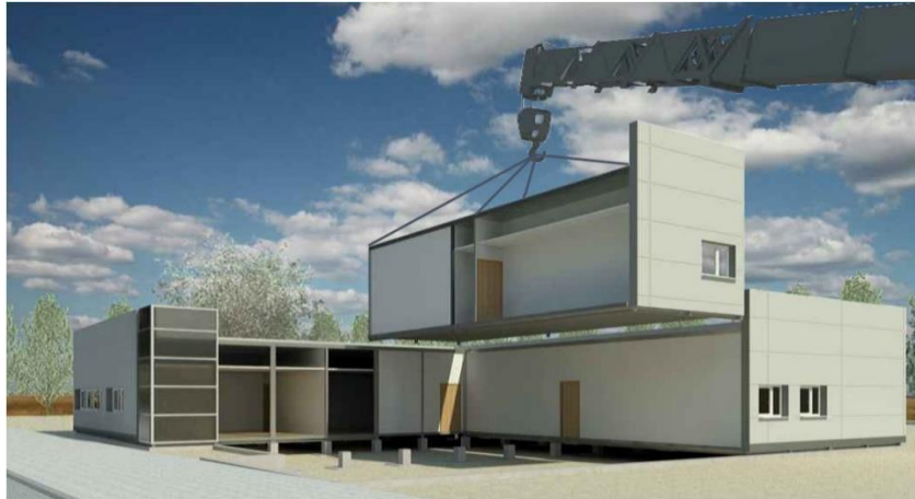
Imagen 44: INSTALACION DE MODULOS APILADOS UNO ENCIMA DE OTRO.
