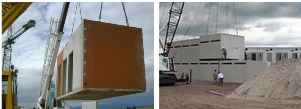
Imagen 21: SISTEMA MODULAR DE HORMIGÓN.
