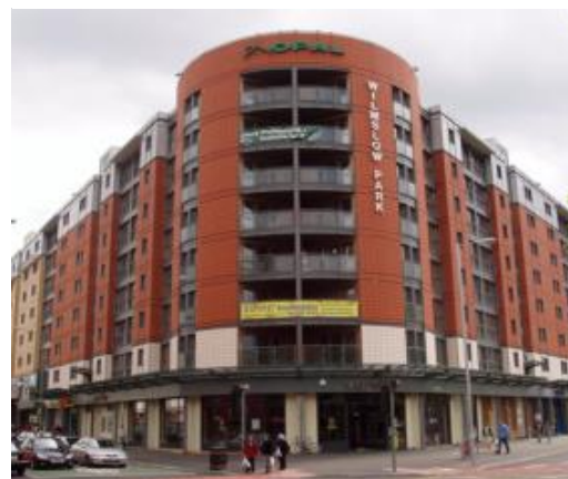
Imagen 41: ESTRUCTURA TIPICA DE PODIO EN LA QUE SE APOYAN SIETE PISOS DE UNIDADES MODULARES.
