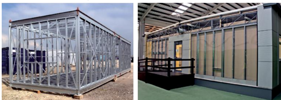
Imagen 22: SISTEMA MODULAR DE ACERO.
