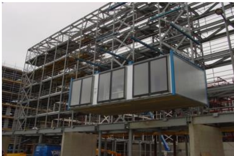
Imagen 43: INSTALACION DE MODULOS DETRÁS DEL MARCO DE ACERO EXTERNO EN MOHO MANCGHESTER.
