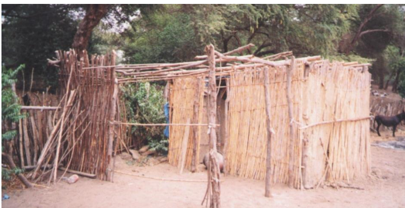
Figura N° 36: Sistemas constructivos vernaculares. Algarrobo y carrizo.
