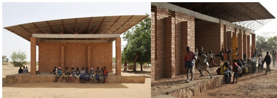
Imagen 16: Techo De Escuela Primaria De Gando
