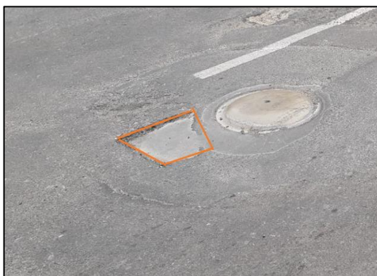
Figura 71. Falla de tipo hundimiento de severidad baja.
