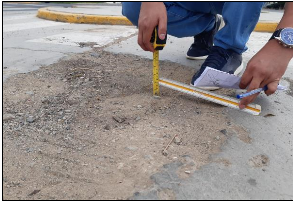
Figura 79. Falla de tipo pulimiento de agregados de severidad alta.
