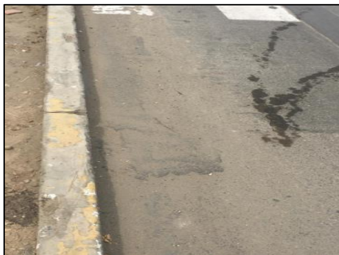
Fig. 32. Falla de tipo corrugación de severidad baja.
