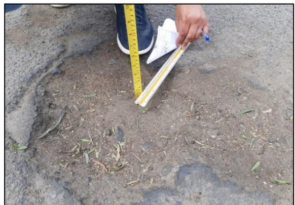
Figura 40. Falla de tipo huevo de severidad baja.
