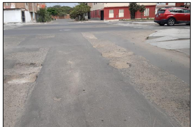
Figura 40. Falla de tipo huevo de severidad baja.
