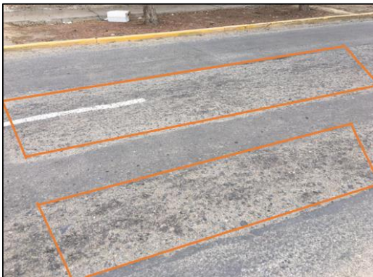
Figura 71. Falla de tipo hundimiento de severidad baja.
