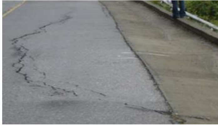
Figura 17. Grietas parabólicas
