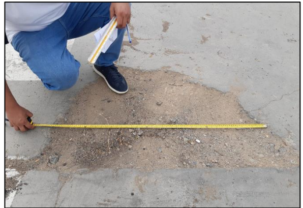
Figura 79. Falla de tipo pulimiento de agregados de severidad alta.
