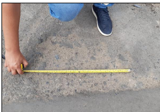
Figura 42. Falla de tipo desprendimiento de agregados de severidad alta y falla de tipo hueco de severidad media.
