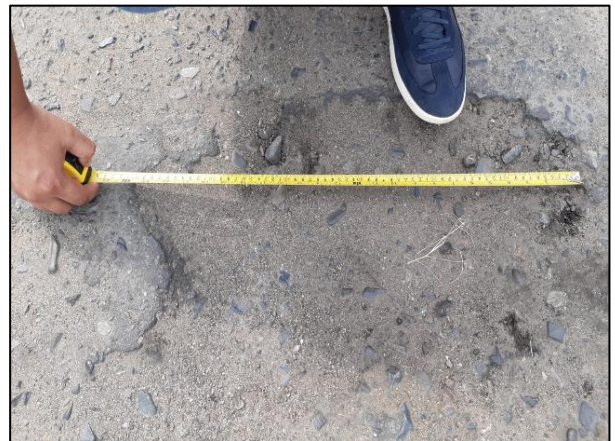
Figura 95. Falla de tipo grieta de borde de severidad media.
