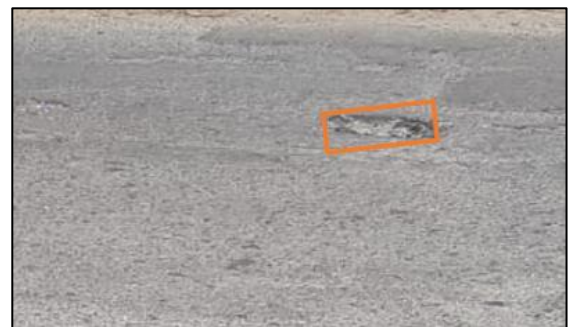
Figura 75. Falla de tipo huecos de severidad baja.
