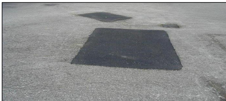
Figura 12. Parcheo en pavimentos
