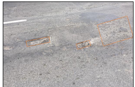
Figura 75. Falla de tipo huecos de severidad baja.
