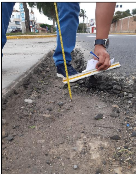
Figura 78. Falla de tipo hueco de severidad alta.
