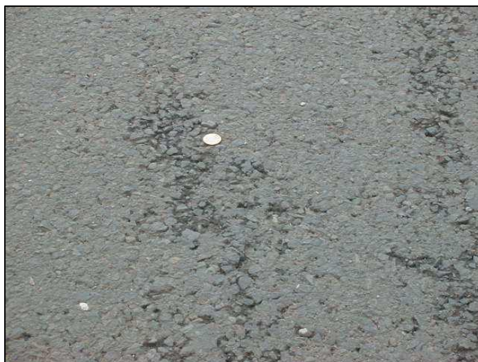
Figura 13. Pulimento de agregados
