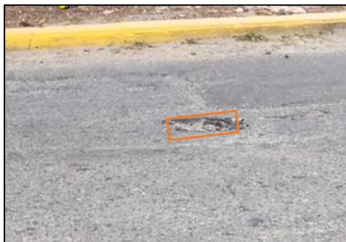
Figura 74. Falla de tipo grieta de borde de severidad media.
