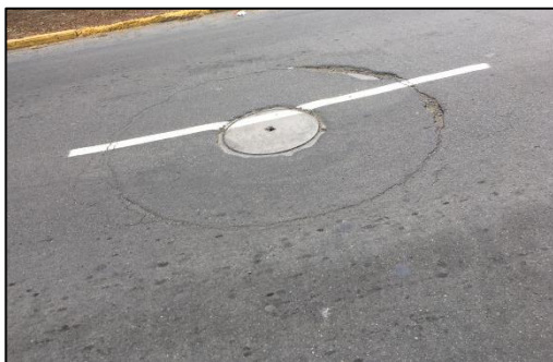
Figura 74. Falla de tipo grieta de borde de severidad media.
