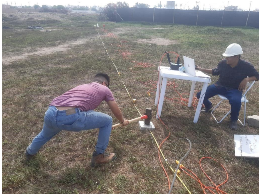
Fotografía 4.7. Generación de ondas sísmicas en los puntos de disparo con la fuente de energía (comba y placa de acero).
