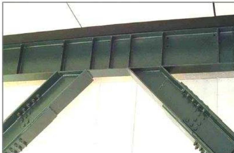
**Figura 34.** Detalle de unión de riostras-enlace y enlace con atizadores/rigidizadores de peralte completo.
