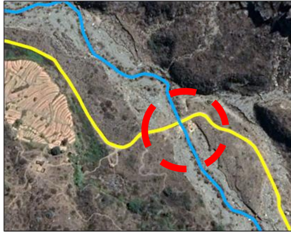
Figura 147 Cruce de la quebrada Purzulate y el trazo proyectado de la carretera Km. 30+660.
