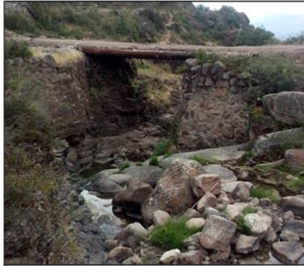
Figura 145 Estado actual de la quebrada y la estructura existente.
