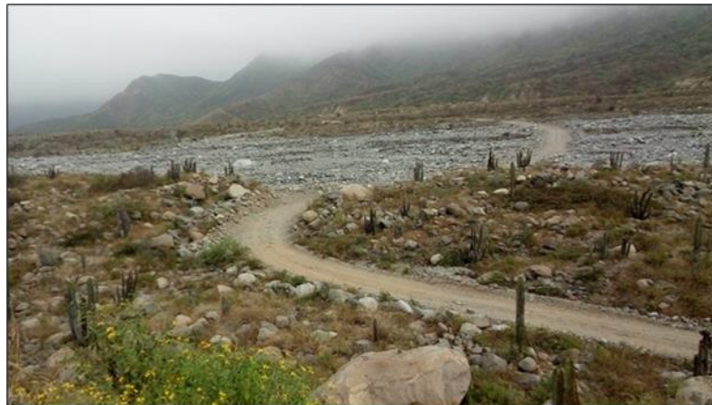
Figura 151 Estado actual de la quebrada y la estructura existente.
