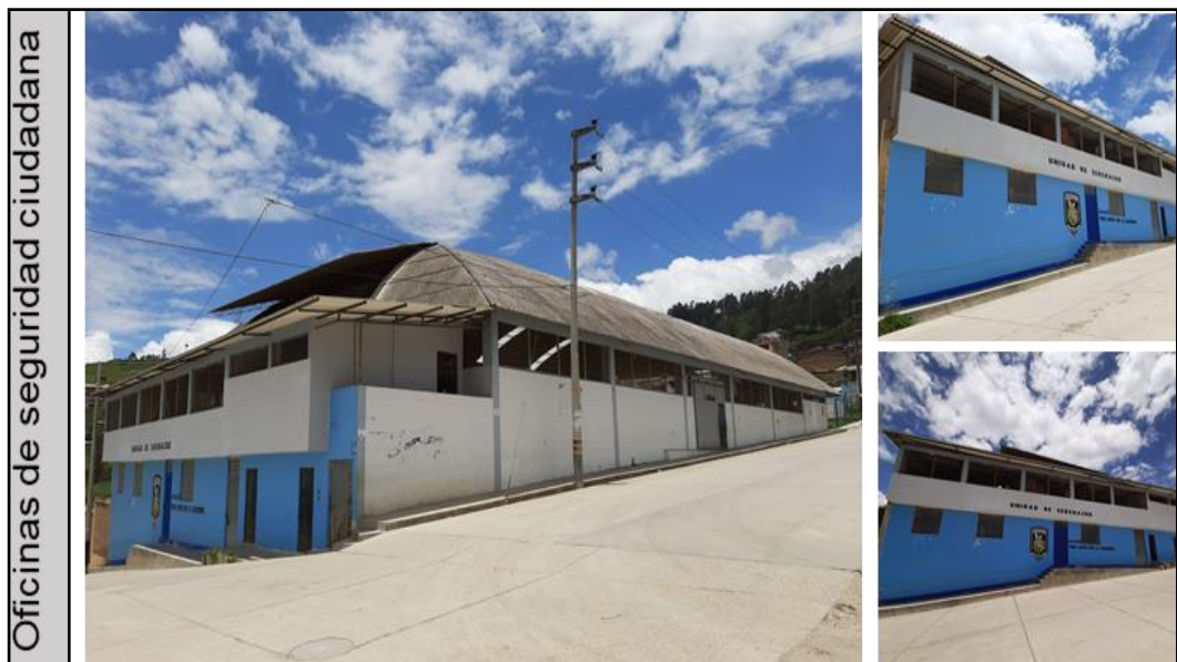
Figura 6: Situación actual de locales municipales - Of. Seguridad Ciudadana
