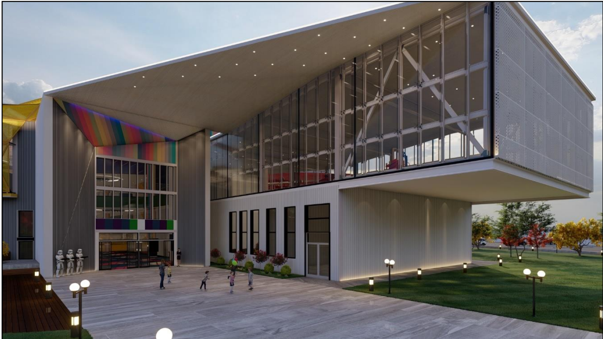
FIG. N° 96. Vista Ingreso Principal y Tienda Souvenir Fuente: Elaboración Propia
