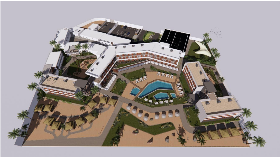
Figura 51: Vista de conjunto
