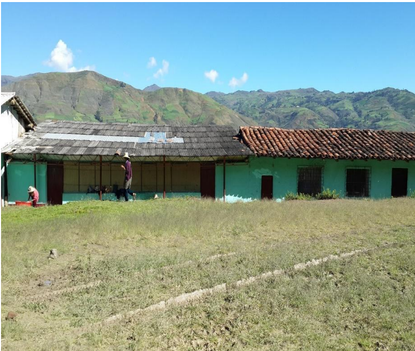
IMAGEN N° 14: Año 2003: Nivelación de Terreno
