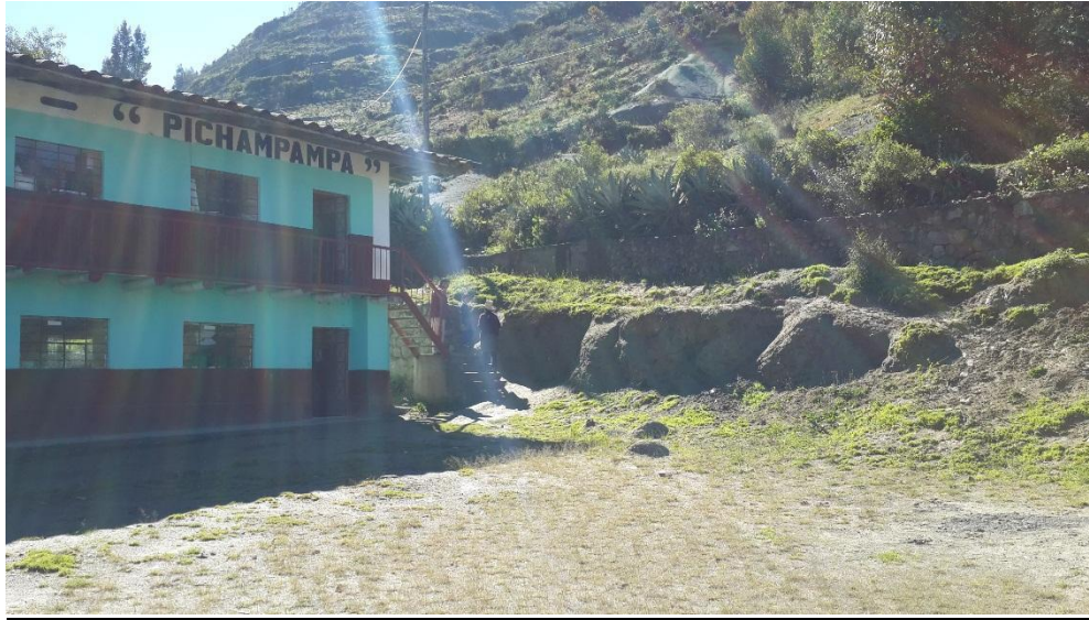
Se puede apreciar la trocha de acceso hacia el módulo existente del Centro Educativo, en el Caserío de Pichampampa.
