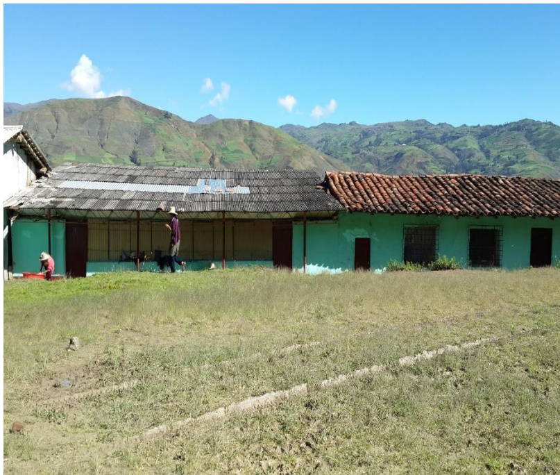
IMAGEN N° 14: Año 2003: Nivelación de Terreno
