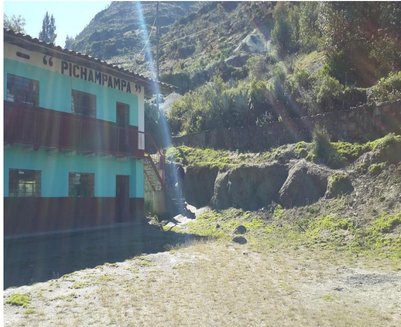
IMAGEN N° 13: Año 1993: Construcción de Aulas
