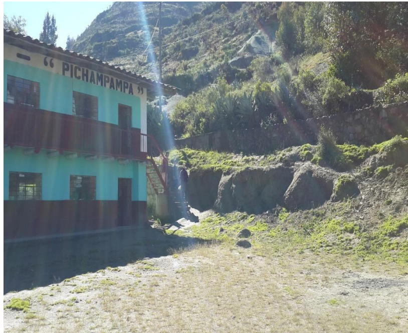
IMAGEN N° 13: Año 1993: Construcción de Aulas
