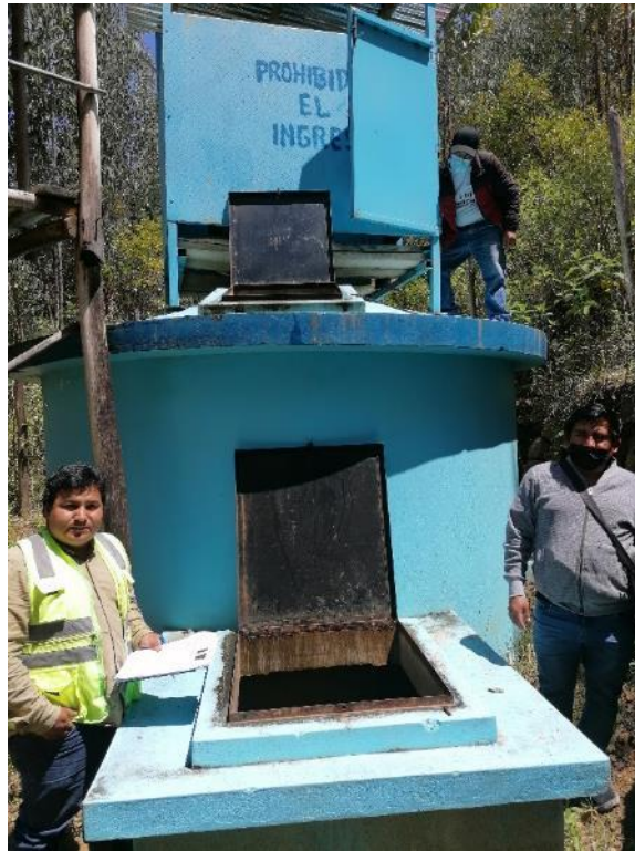
Reservorio del sistema de agua potable de Moyan.
