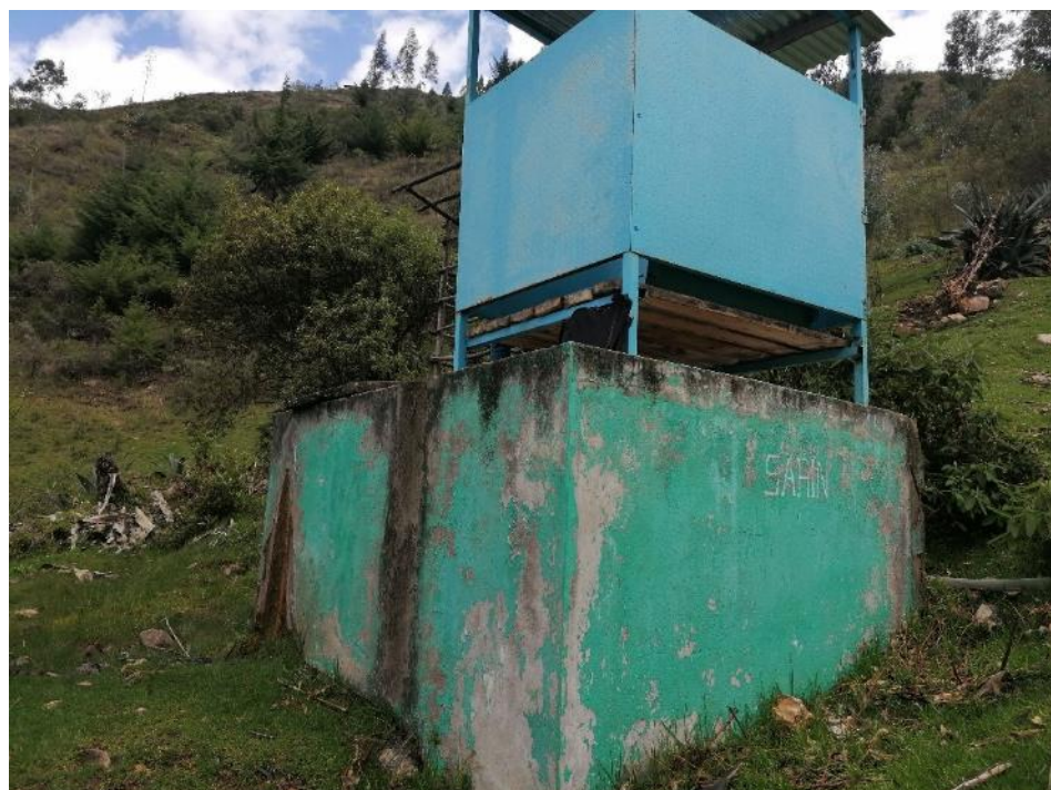
Imagen 6. Estado de Reservorio N° 02- Moyan
