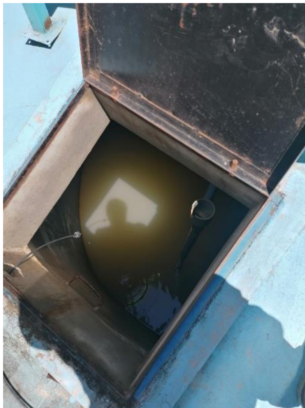
Interior del reservorio - Moyan
