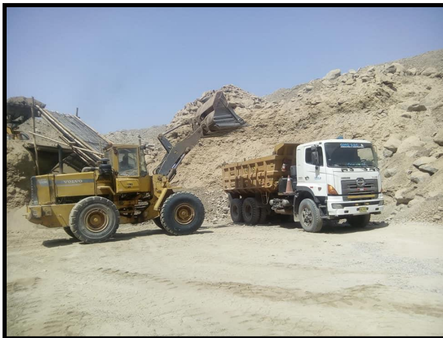
Figura 31. Extracción de agregados desde Cantera Trapiche – Lima.
