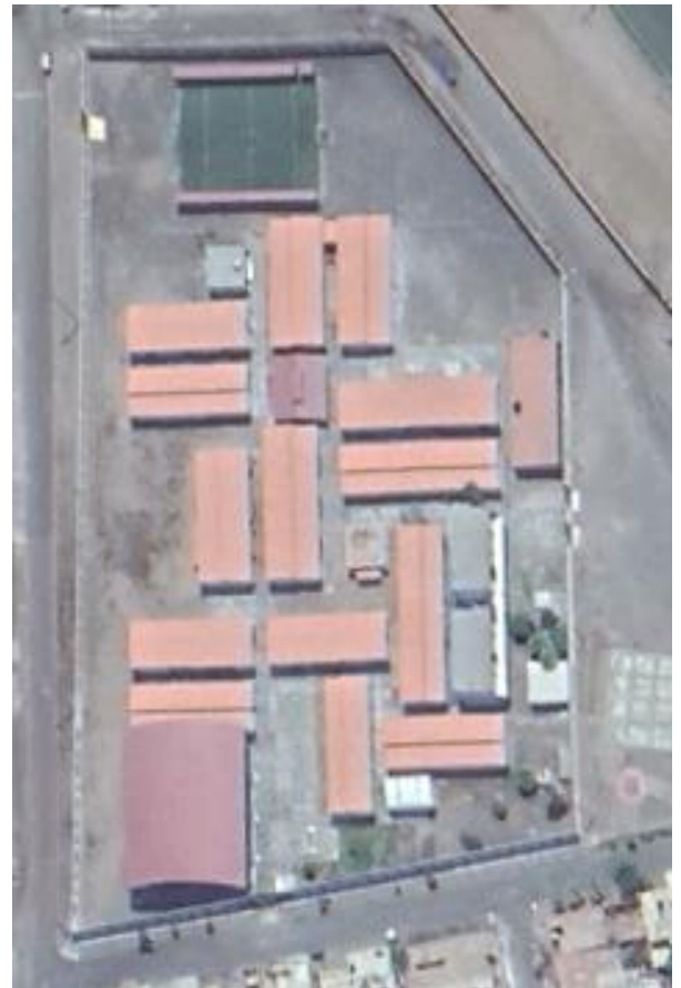
IMAGEN N°27: VISTA AEREA DEL TERRENO DE LA I.E. MIGUEL GRAU SEMINARIO FUENTE: GOOGLE EARTH
