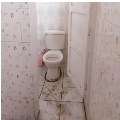
IMAGEN N°39: ESTADO ACTUAL – BAÑO PRIMARIA FUENTE: VISITA DE CAMPO
