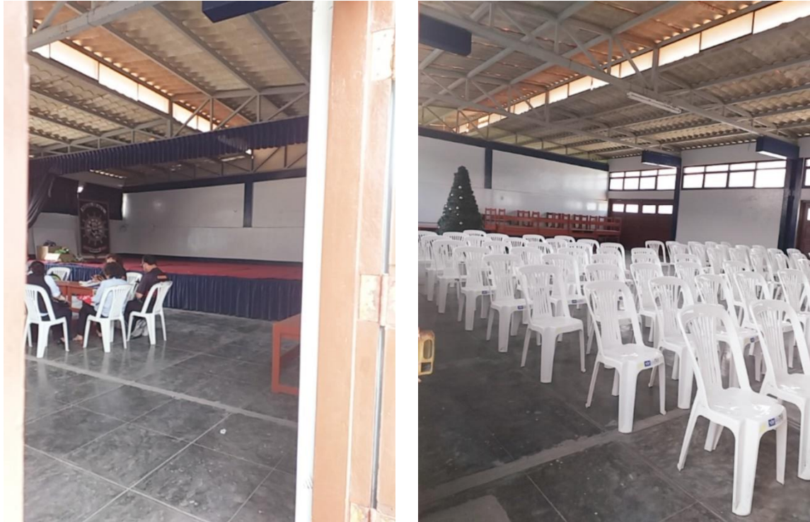
IMAGEN N°41: ESTADO ACTUAL – AUDITORIO FUENTE: VISITA DE CAMPO
