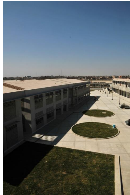
IMAGEN 17: VISTA INTERIOR -COLEGIO PUBLICO – JOSE DE SAN MARTIN FUENTE: PLATAFORMA ARQUITECTURA
