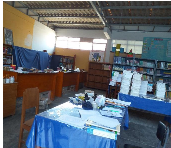
IMAGEN N°37: ESTADO ACTUAL DE MOBILIARIO EN BIBLIOTECA FUENTE: VISITA DE CAMPO
