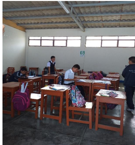
IMAGEN N°31: ESTADO ACTUAL INTERIOR DE AULAS DE CLASE FUENTE: VISITA DE CAMPO
