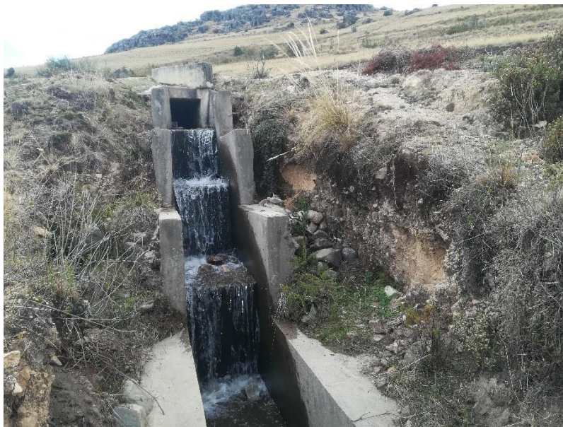
Fotografía 04: Vista del desnivel 2, tramo de canal Uchucubamba Fuente: propia
