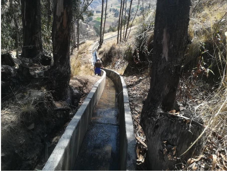
Fotografía 07 : Vista del canal Rectangular de concreto de Uchucubamba . Fuente: Propia
