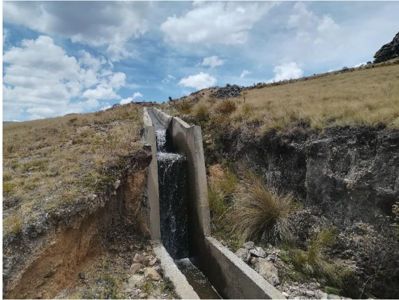
Fotografía 03: Vista del desnivel 1, tramo de canal Uchucubamba Fuente: propia
