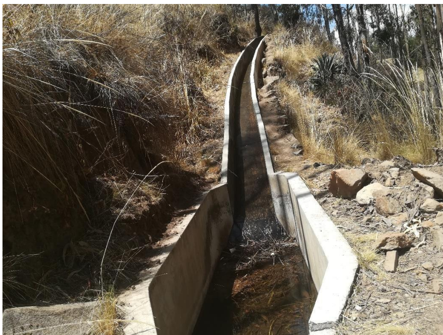
Fotografía 01 : Vista de tramo de canal Uchucubamba Fuente: propia
