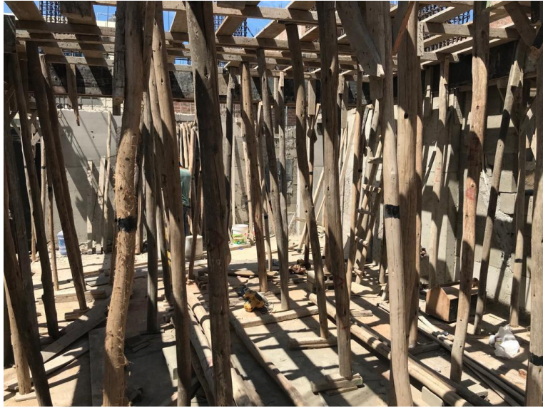
Figura 30: Encofrado tradicional de losa aligerada en "Residencial Home Green" (2021).
