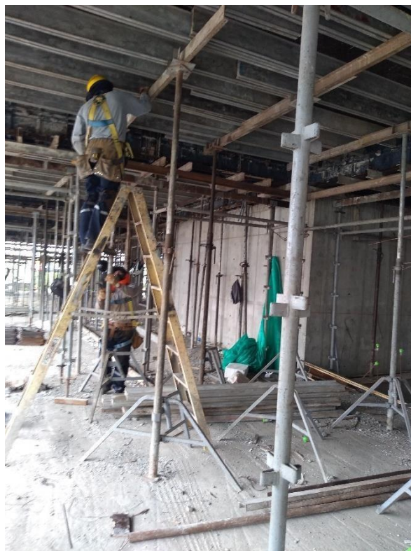
Figura 26: Desencofrado metálico de losa aligerada en "Construcción, edificios oficinas el Golf" (2021).
