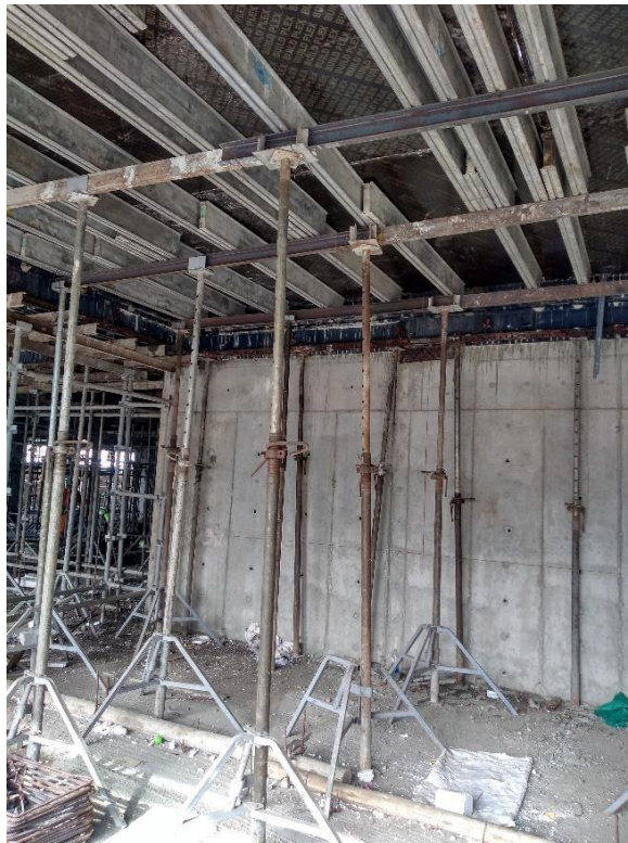
Figura 25: Encofrado metálico de losa aligerada en "Construcción, edificios oficinas el Golf" (2021).
