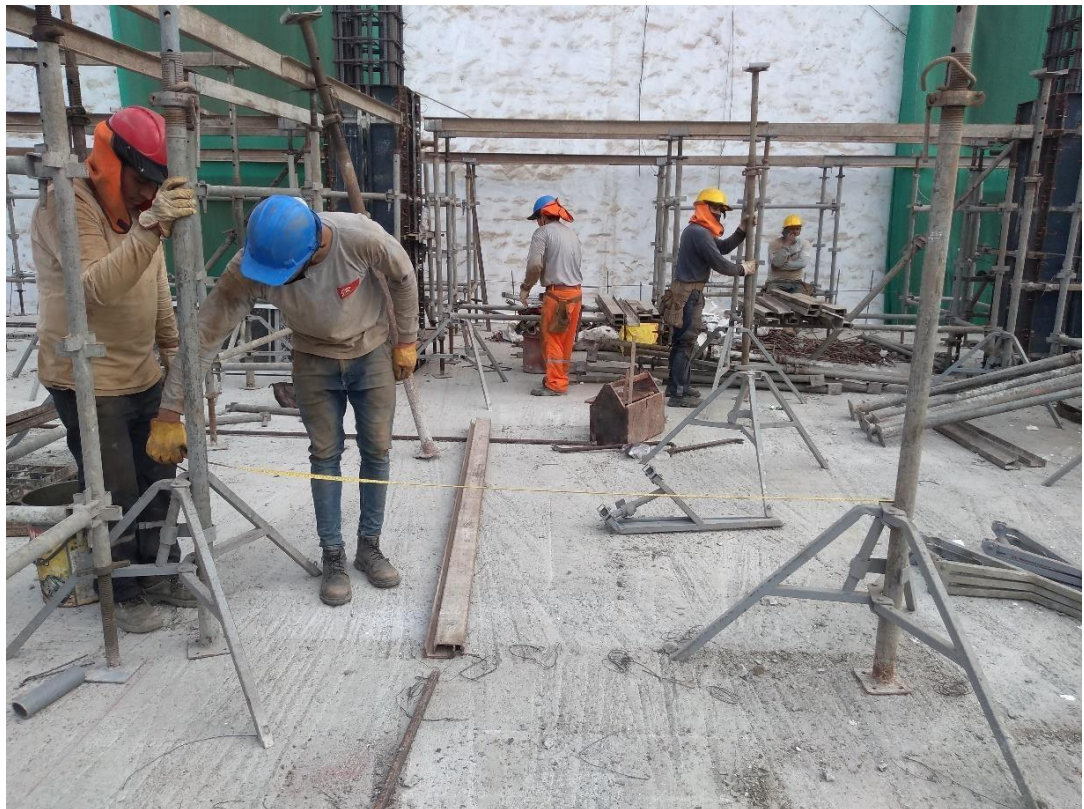
Figura 28: Tomando medidas reglamentarias de 1.50m entre puntales.
