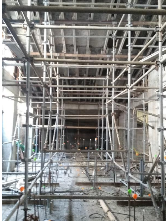
Figura 27: Estructuración de puntales a gran altura.
