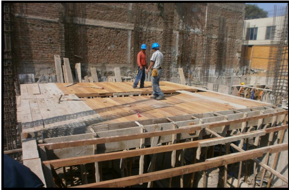
Foto 3: Encofrado de techo
