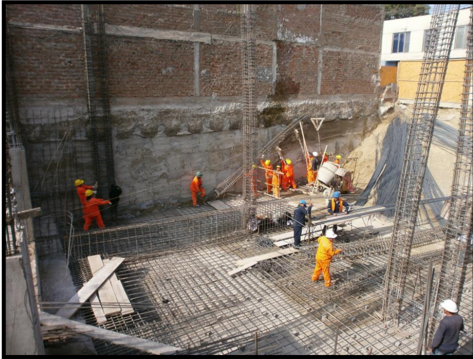
Foto 1: Trabajos de cimentación del proyecto.
