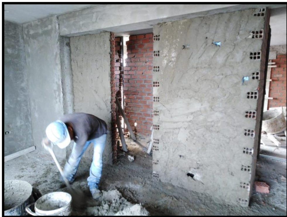
Foto 6: Tarrajeo de muros interiores
