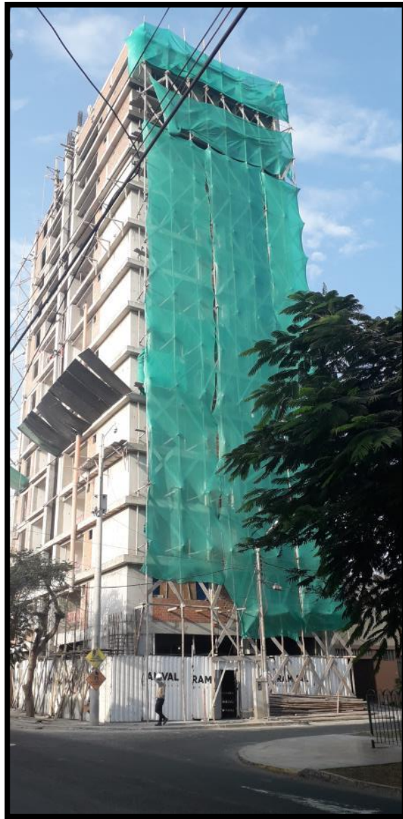
Foto 7: Tarrajeo de muros exteriores
