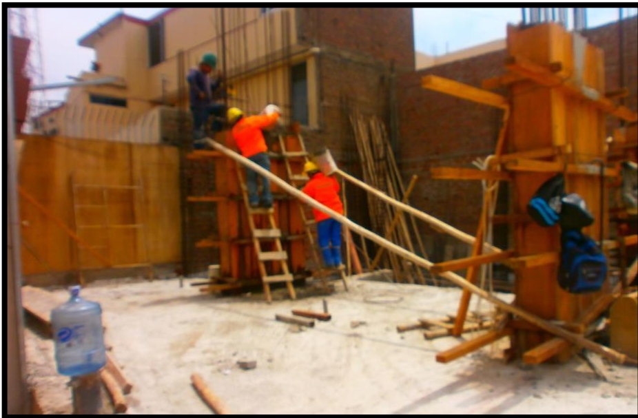
Foto 4: Encofrado y vaceado de columnas
