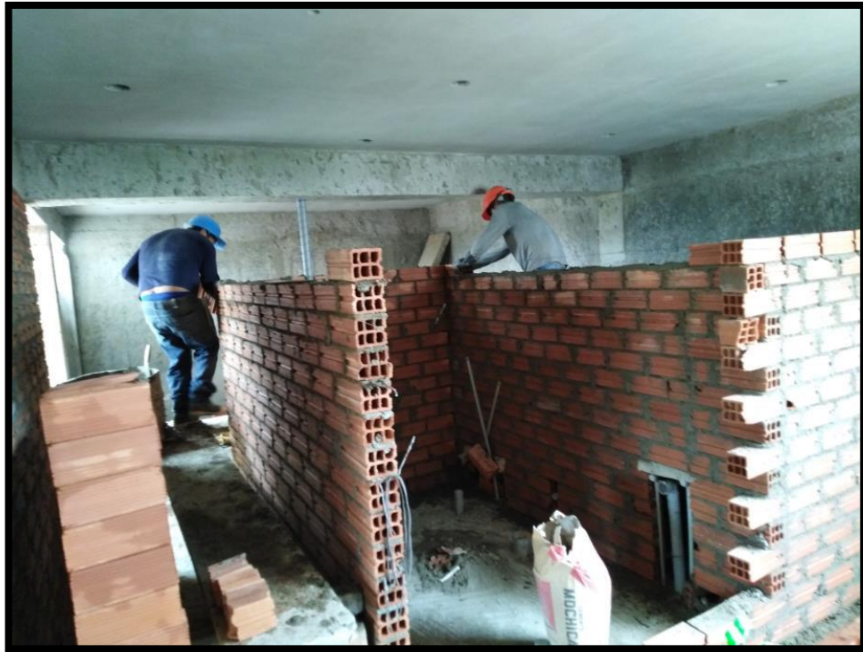
Foto 5: Asentado de ladrillo.
