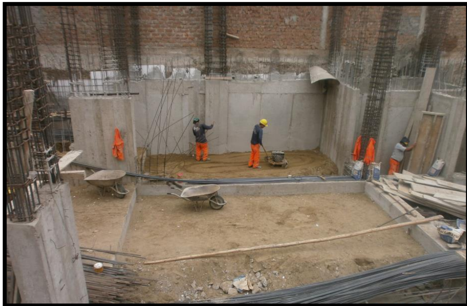
Foto 2: Trabajos de relleno con material en el proyecto
